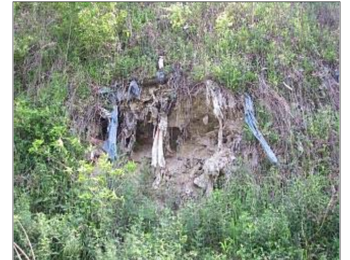
写真1.2.2 浸透水の吸出しによる崩落
