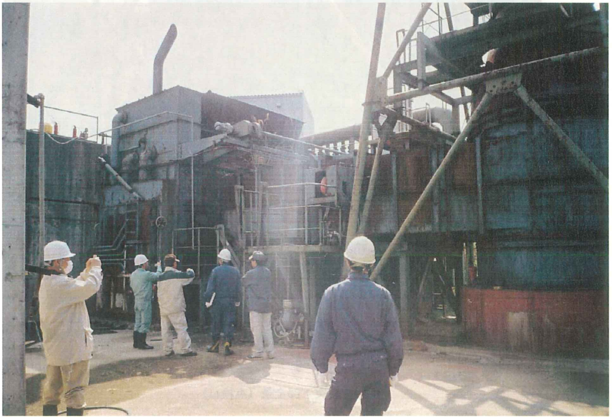
燃烧炉下部（灰出口）
