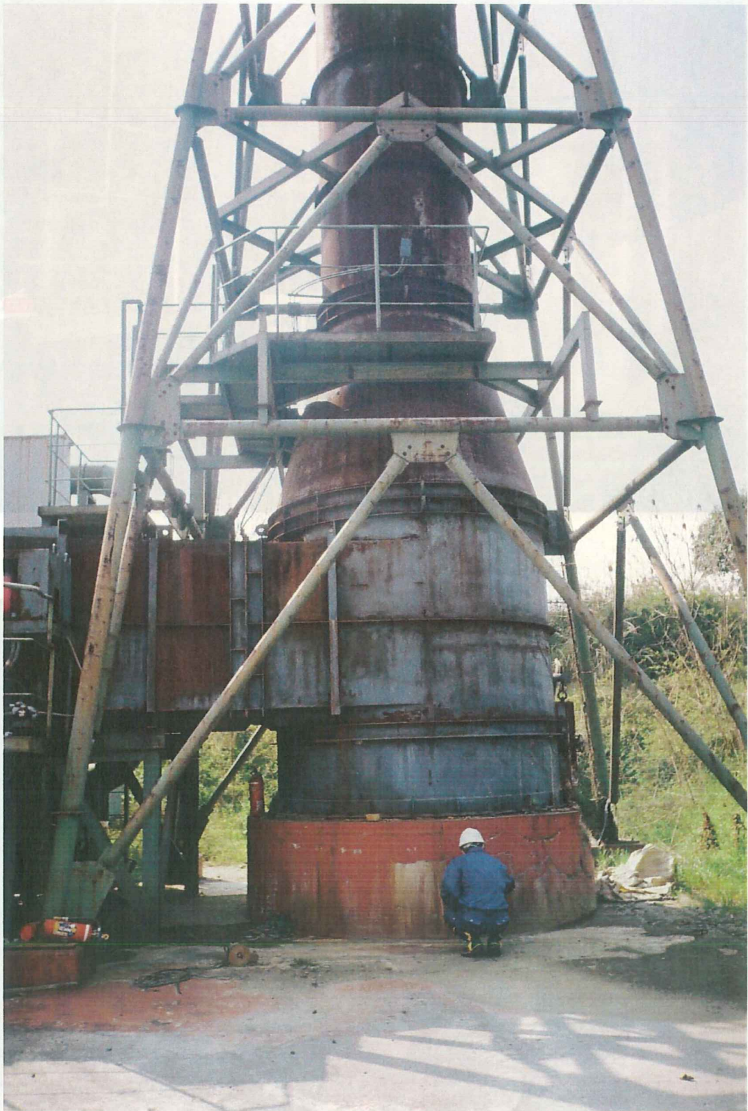
②煙突下部全景（点検口）
