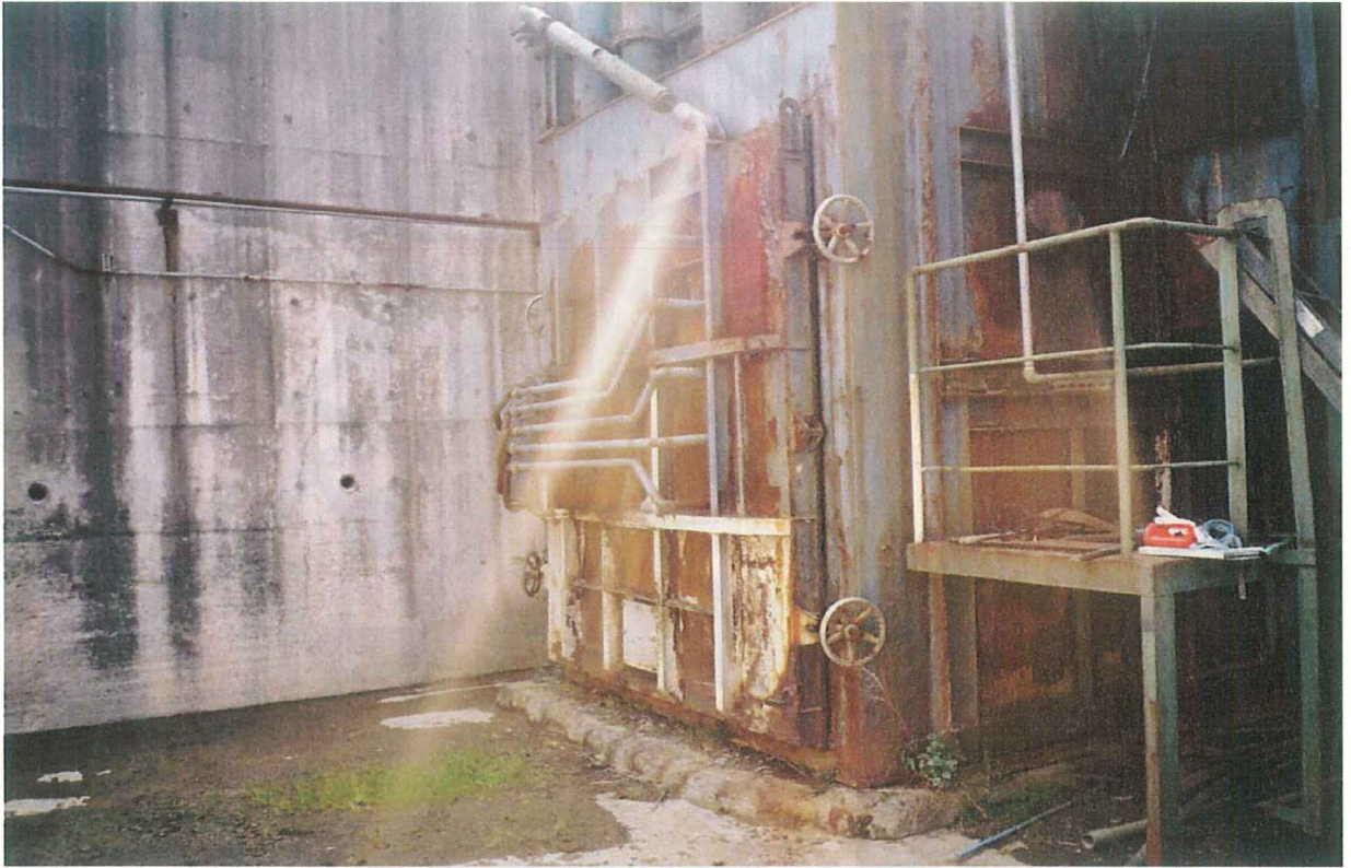
燃烧炉下部（灰出口）
