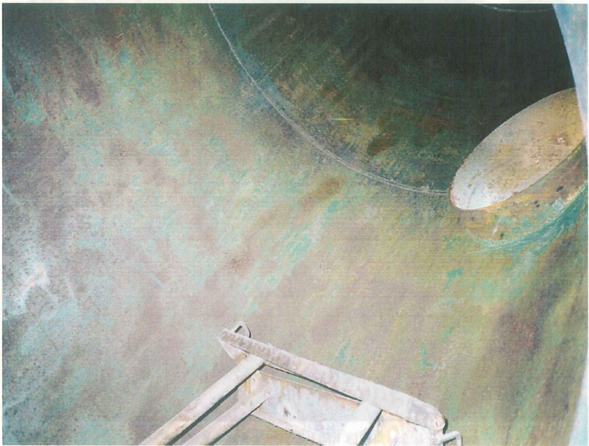
④煙突内部
