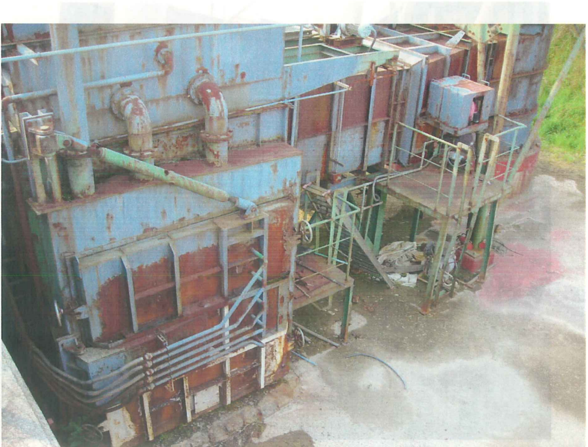
① 燃焼炉下部 (灰出口)
