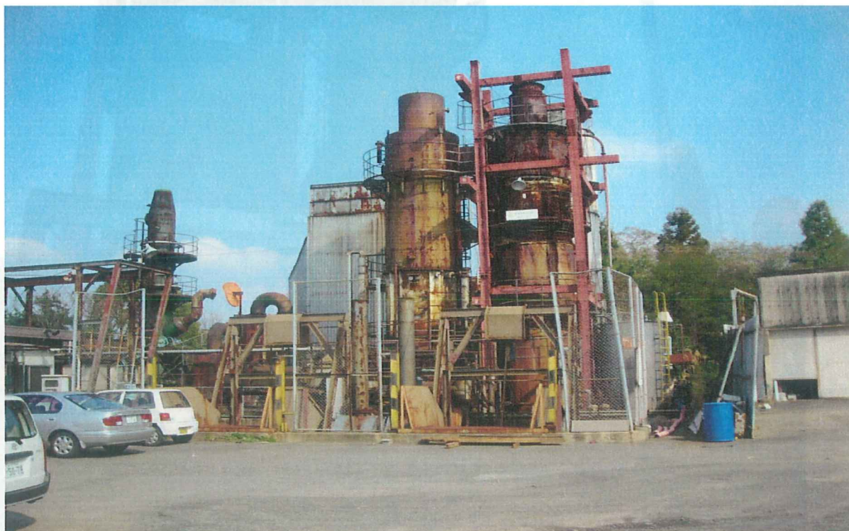
南側焼却炉全景
