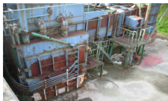
燃烧炉下部（灰出口）
