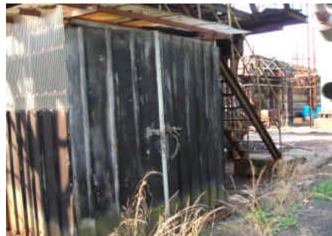
集塵機下部（灰出し口）
