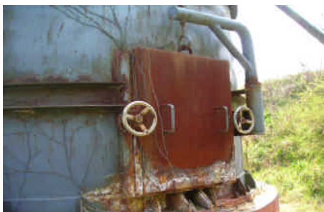
煙突下部（点検口）
