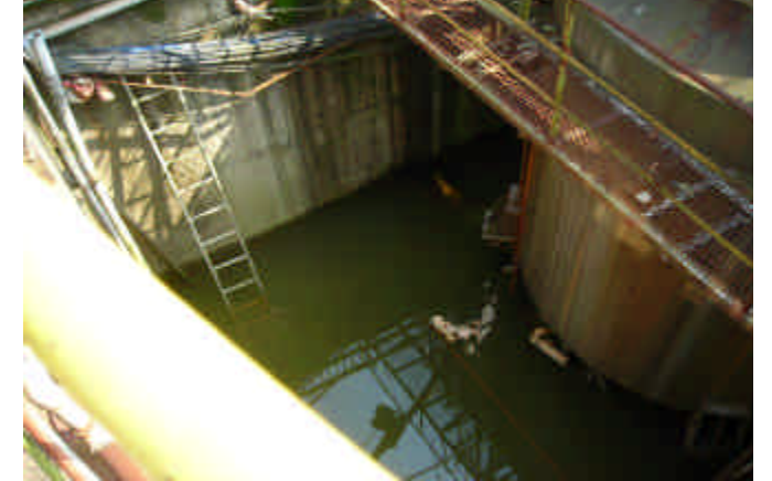
焼却炉乾留炉水没部
