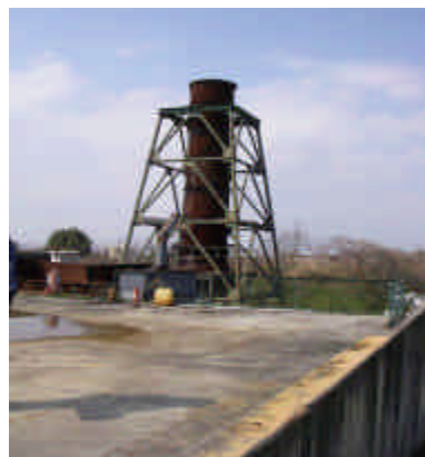
東側焼却炉全景
