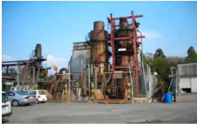
南側焼却炉全景
