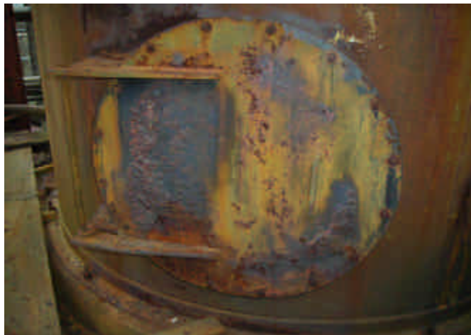
冷却塔点検口（拡大部）
