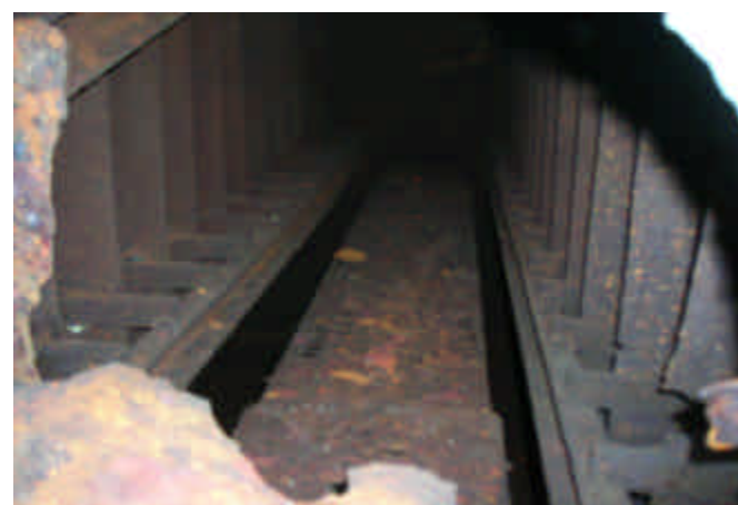
集塵機上部（内部）
