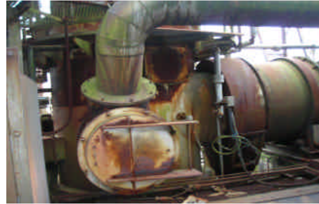
冷却塔下部（点検口）
