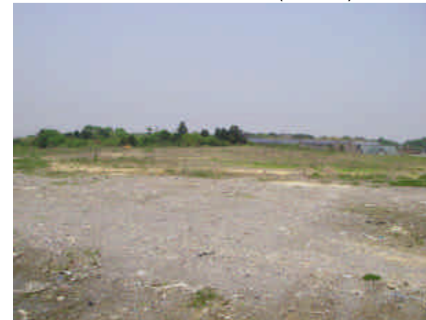
写真11 覆土状況(上部平坦部)
