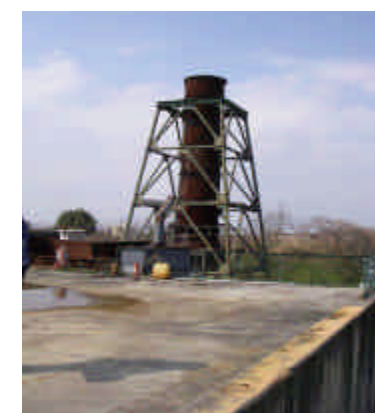
東側焼却炉全景
