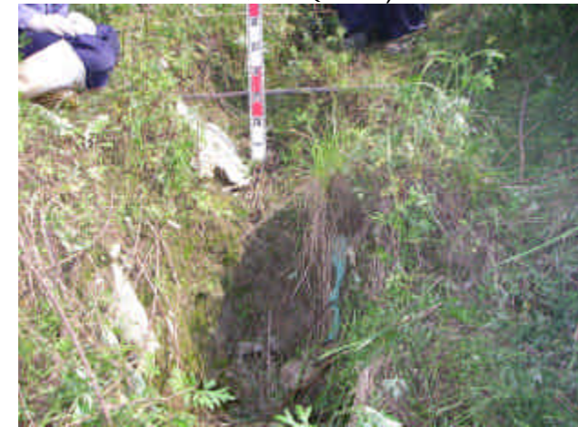
写真9 たて排水路(素掘り)
