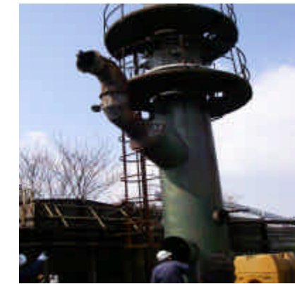
南側焼却炉煙突
