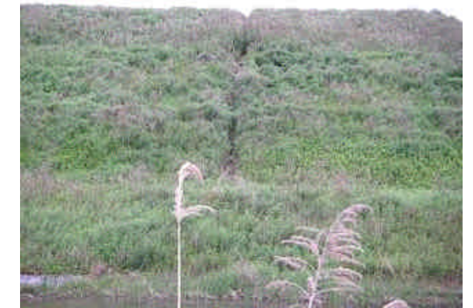
写真10 たて排水路（遠景）
