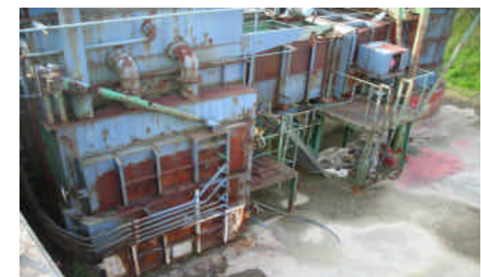
東側焼却炉 燃焼炉下部（灰出口）
