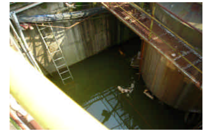
南側焼却炉 焼却炉乾留炉水没部
