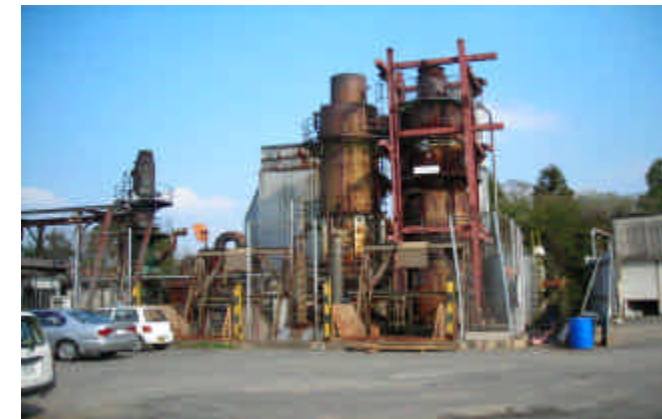
南側焼却炉全景
