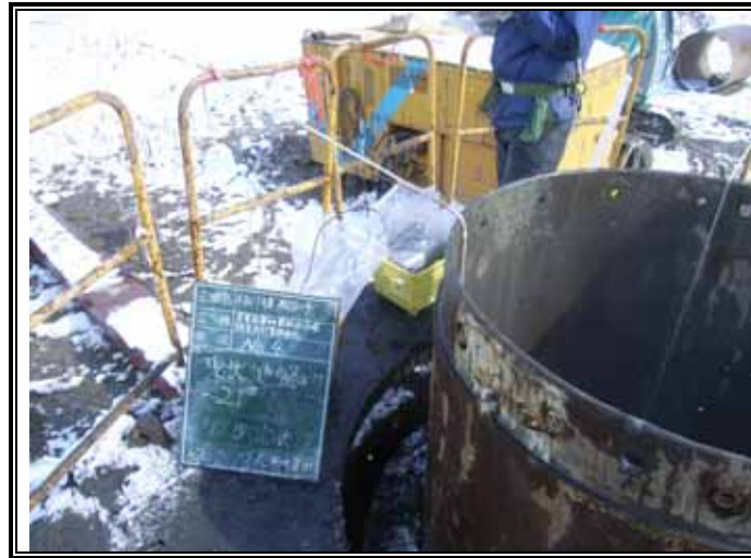
ガス測定状況(GL-21.00m)
