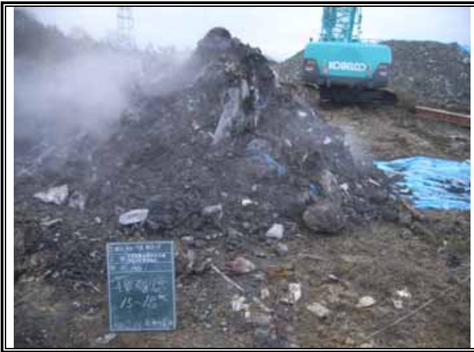
掘削廃棄物土(GL-15.00 ~ -18.00m)
