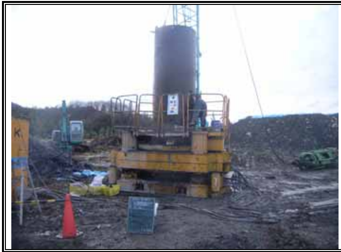
ケーシング立て込み状況
