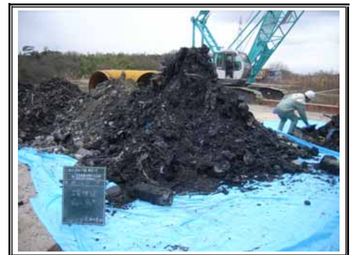
掘削廃棄物土(GL-6.00 ~ -9.00m)
