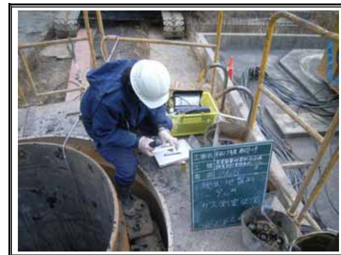
ガス測定状況(GL-9.00m)
