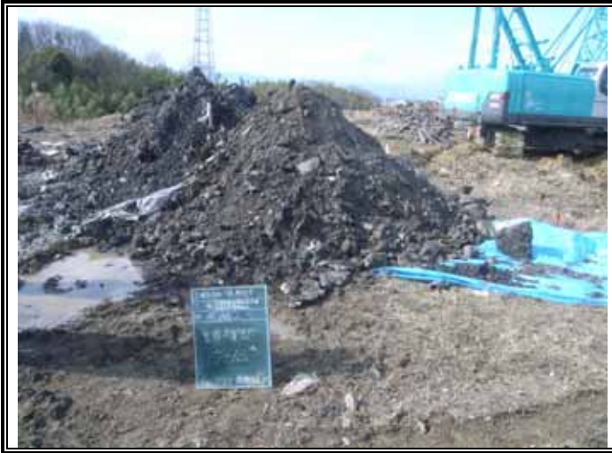
掘削廃棄物土(GL-15.00 ~ -18.00m)
