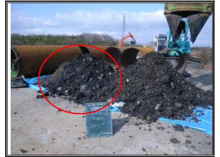
掘削廃棄物土(GL-0.00 ~ -3.00m)
