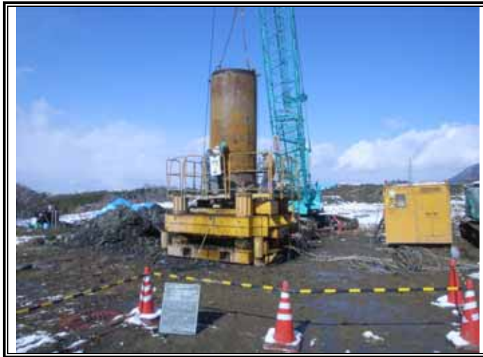
ケーシング立て込み状況
