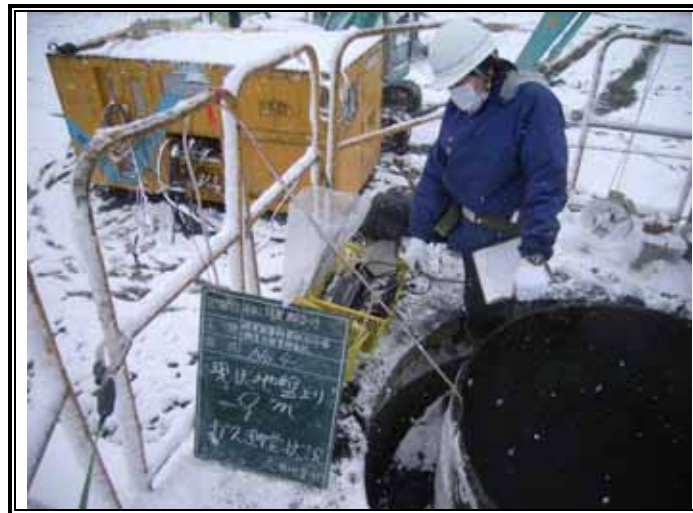
ガス測定状況(GL-9.00m)
