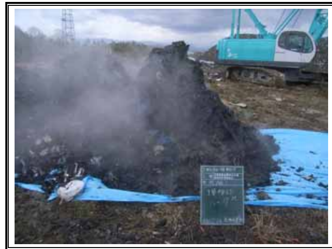
掘削廃棄物土(GL-6.00～-9.00m)
