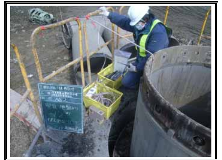
ガス測定状況(GL-12.00m)
