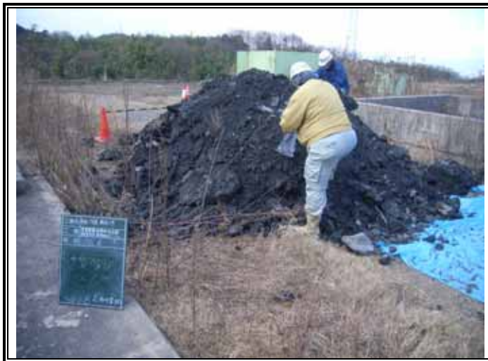
掘削廃棄物土(GL-3.00~-6.00m)
