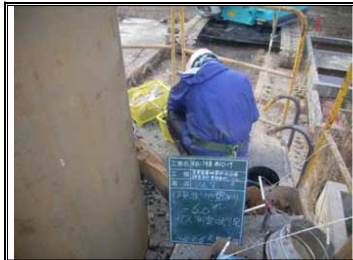
ガス測定状況(GL-6.00m)
