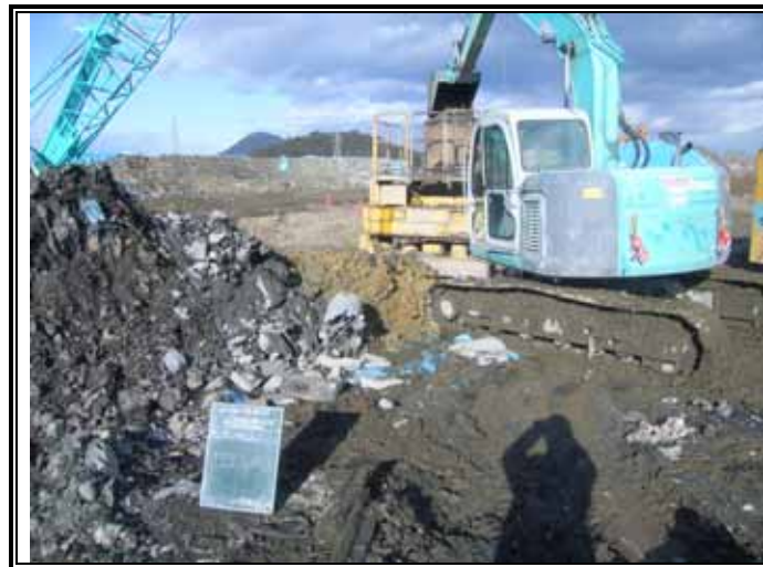
バックホウによる埋戻状況
