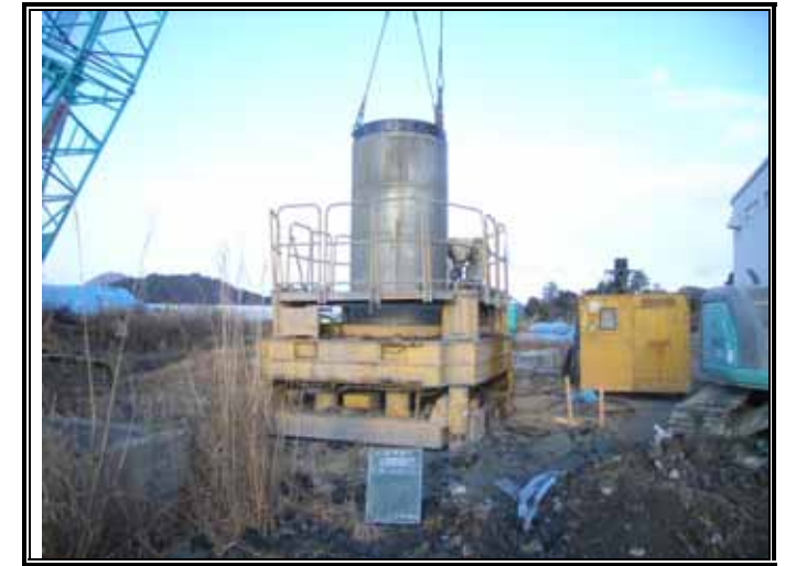
ケーシング抜管状況
