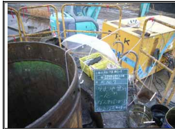
ガス測定状況(GL-18.00m)
