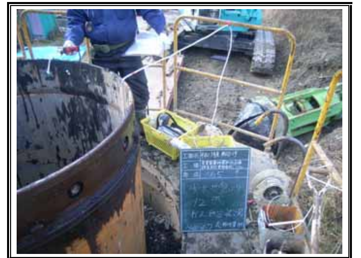
ガス測定状況(GL-12.00m)
