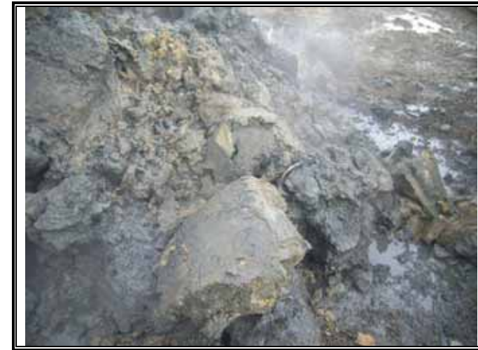
掘削土山 (GL-21.00 ~ 25.00m)
