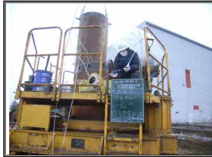
ガス測定状況(GL-12.00m)
