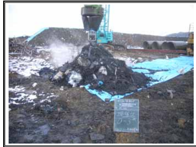
掘削廃棄物土(GL-3.00～-6.00m)
