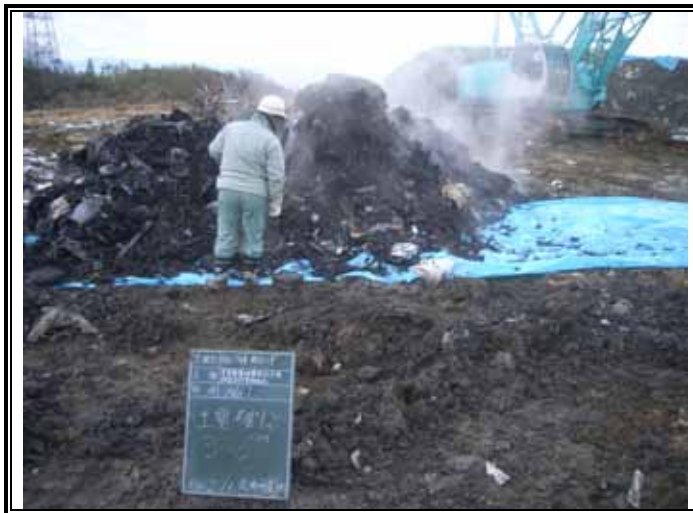
掘削廃棄物土(GL-3.00～-6.00m)
