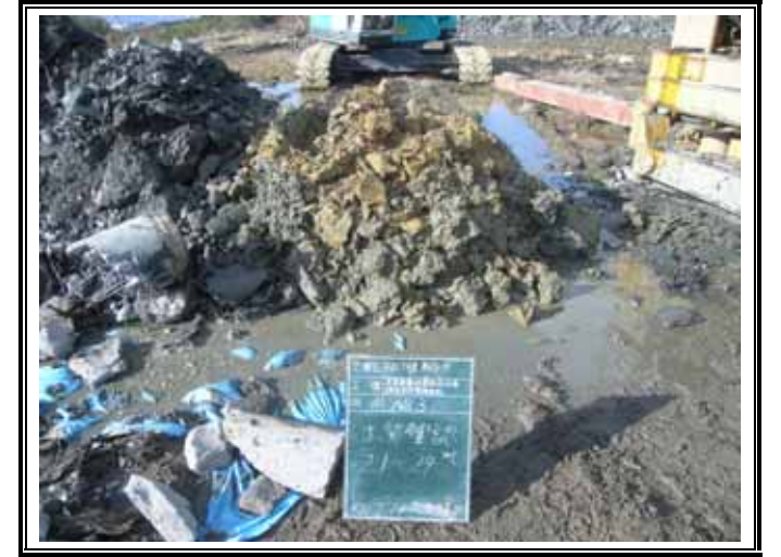
掘削土地山(GL-21.00 ~ -24.00m)
