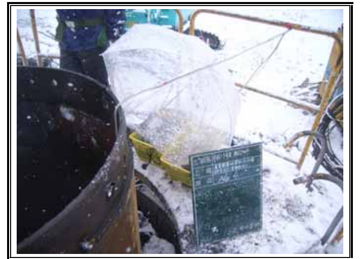
ガス測定状況(GL-12.00m)
