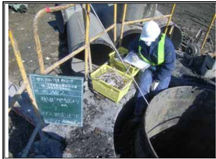
ガス測定状況(GL-9.00m)
