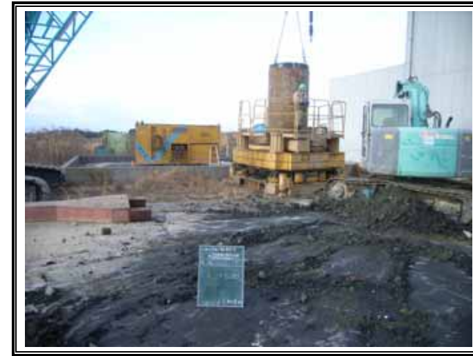
ケーシング抜管状況
