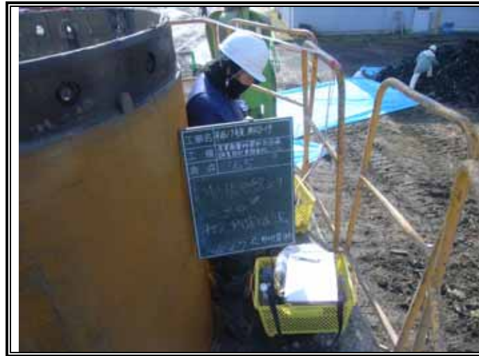
ガス測定状況(GL-3.00m)
