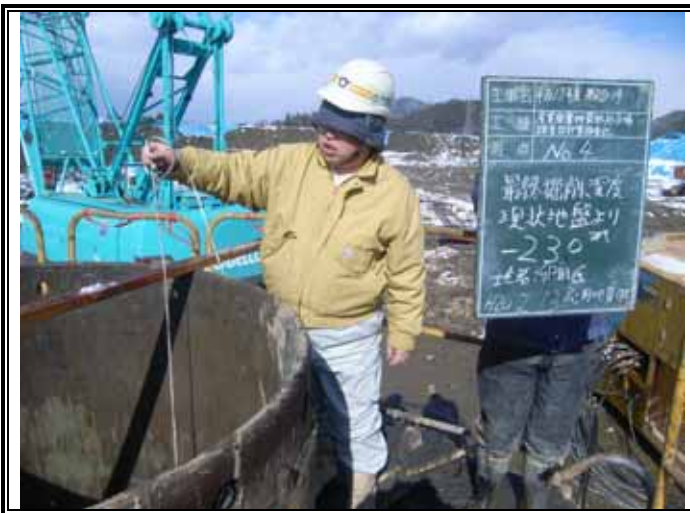
掘削深度確認 (GL-23.00m)
