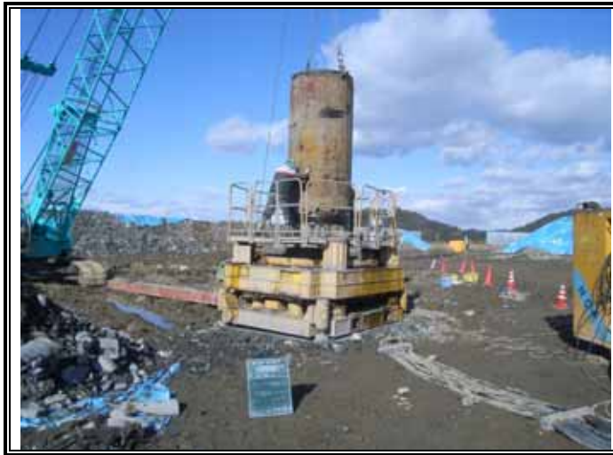
ケーシング立て込み状況
