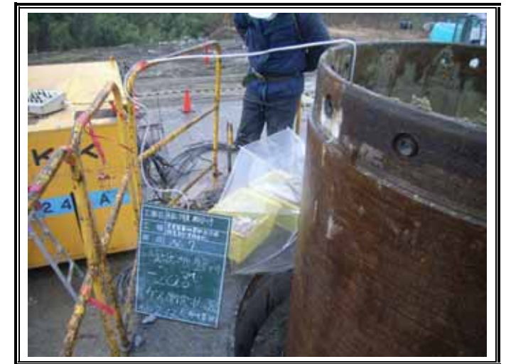
ガス測定状況(GL-20.00m)
