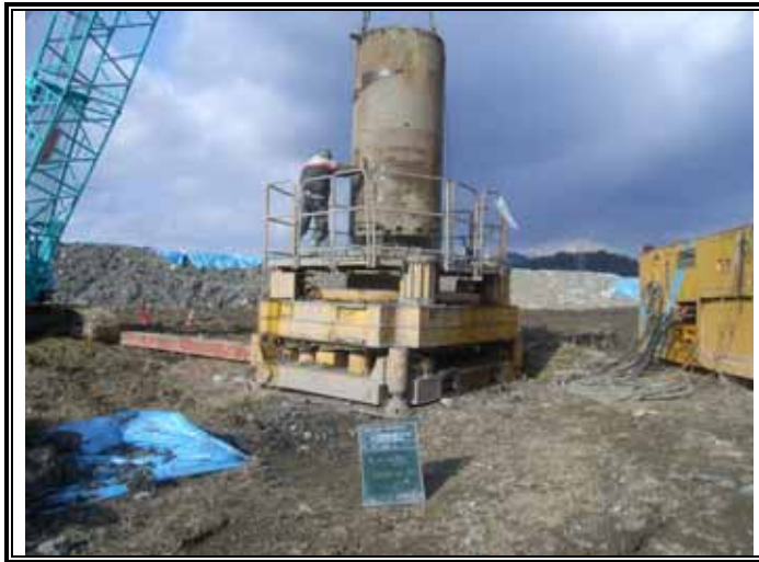
ケーシング立て込み状況
