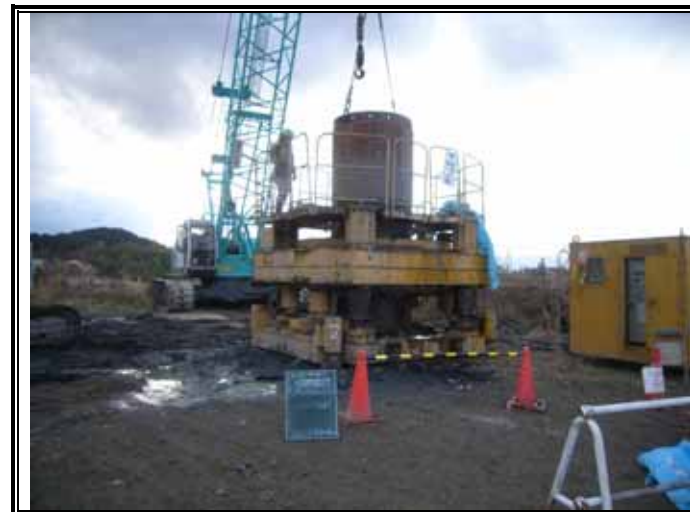
ケーシング抜管状況
