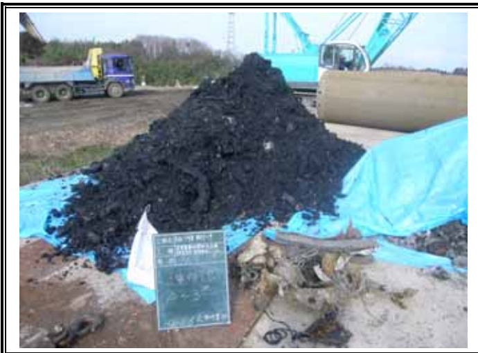
掘削廃棄物土(GL-0.00 ~ -3.00m)
