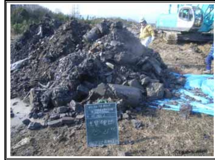
掘削廃棄物土(GL-18.00 ~ -21.00m)
