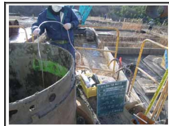
ガス測定状況(GL-15.35m)
