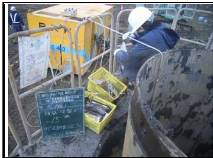
ガス測定状況(GL-15.00m)
