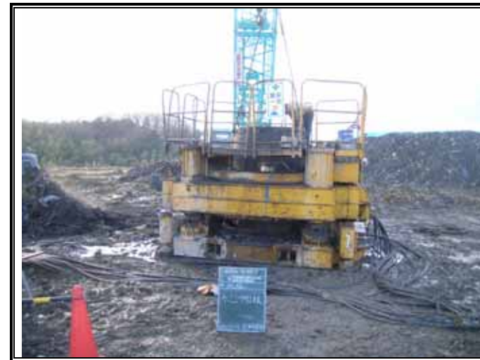
ケーシング抜管状況
