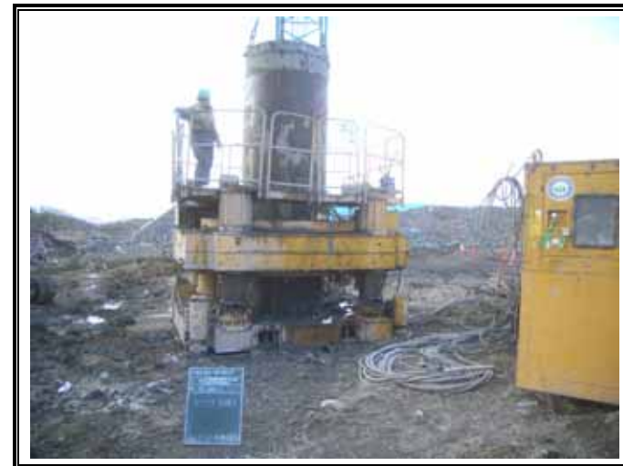
ケーシング抜管状況
