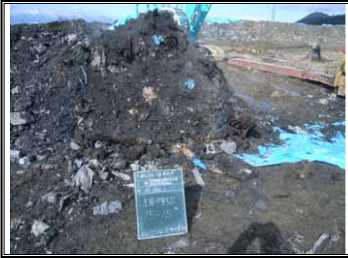
掘削廃棄物土(GL-15.00 ~ -18.00m)
