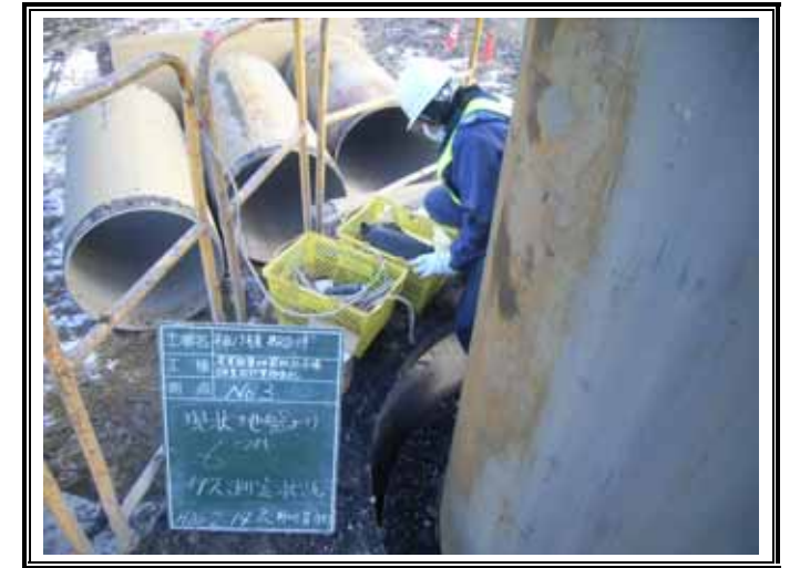
ガス測定状況(GL-6.00m)
