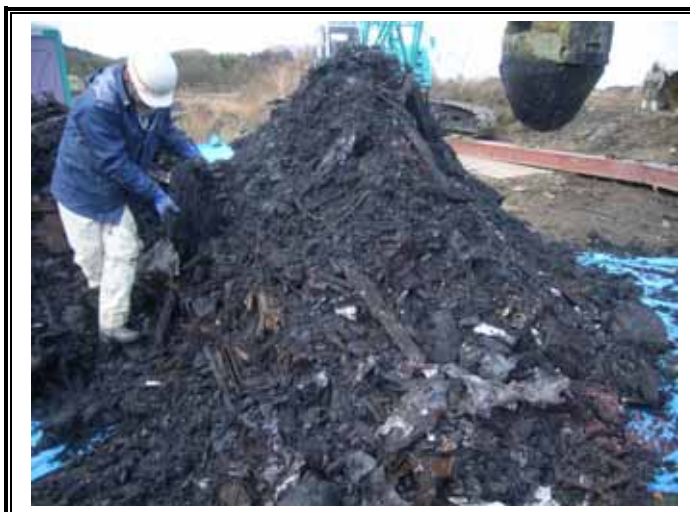
掘削廃棄物土(GL-9.00~-12.00m)
