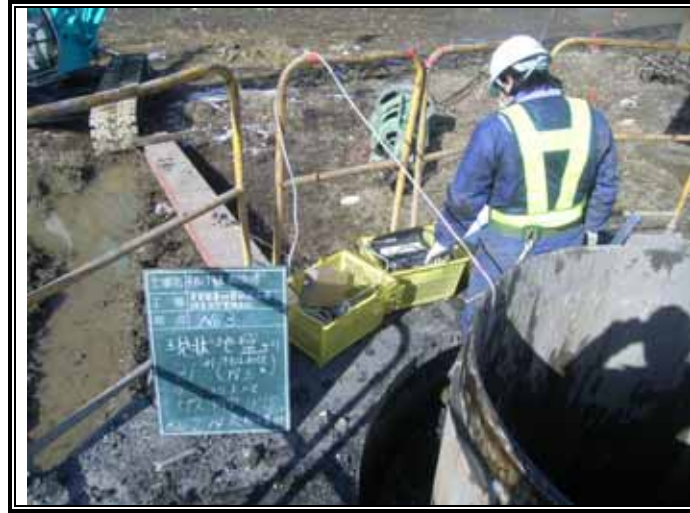
ガス測定状況(GL-21.00m)
