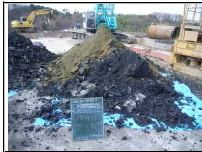
掘削廃棄物土(GL-9.00 ~ -12.00m)
