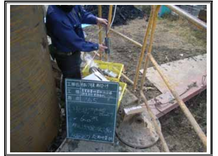
ガス測定状況(GL-6.00m)
