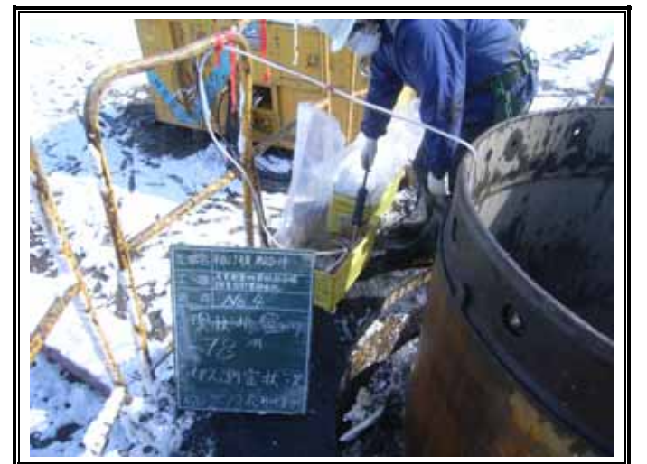
ガス測定状況(GL-18.00m)
