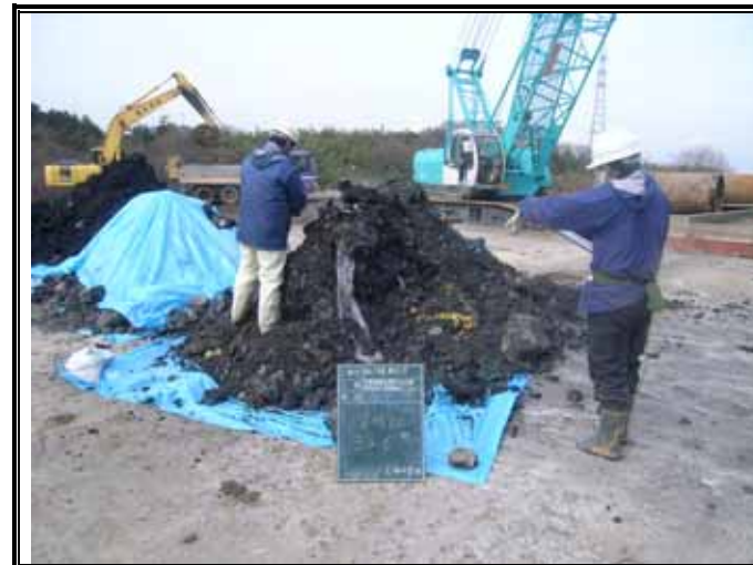
掘削廃棄物土(GL-3.00 ~ -6.00m)
