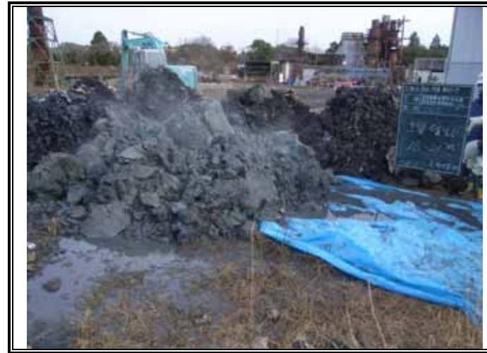
掘削土山 (GL-18.00 ~ 21.00m)
