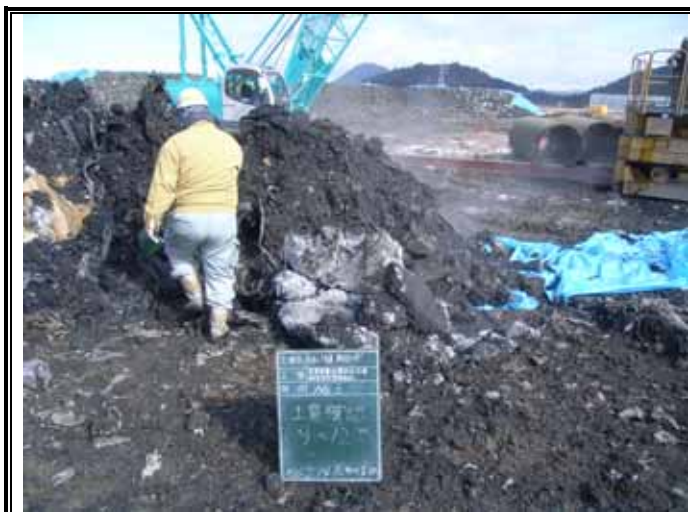
掘削廃棄物土(GL-9.00~-12.00m)
