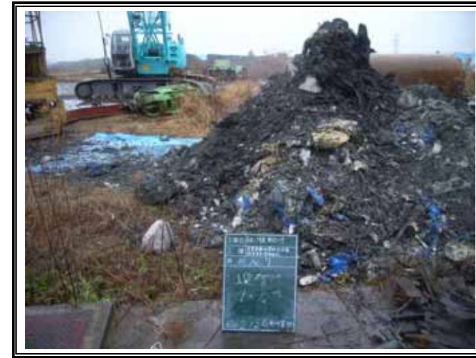
掘削廃棄物土(GL- 9.00~-12.00m)
