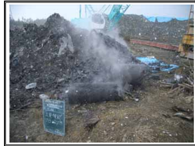
掘削廃棄物土(GL-18.00 ~ -21.00m)
