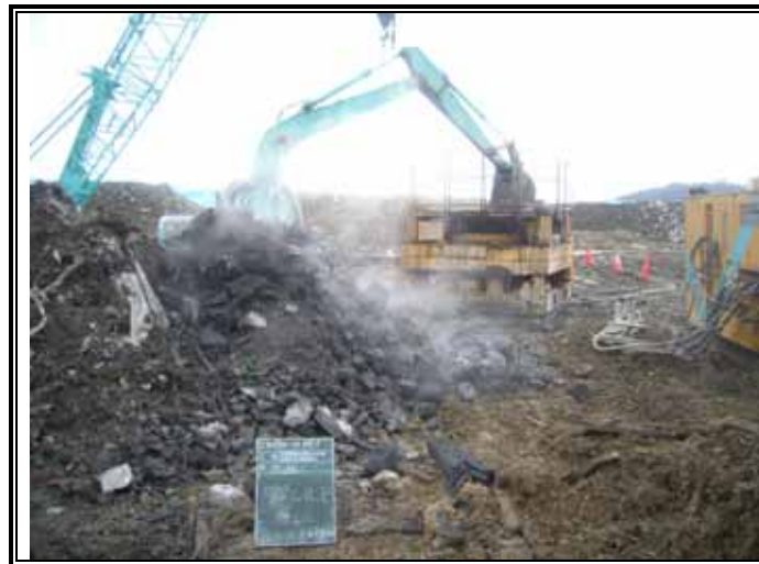
バックホウによる埋戻状況
