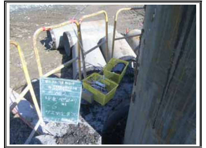
ガス測定状況(GL-6.00m)
