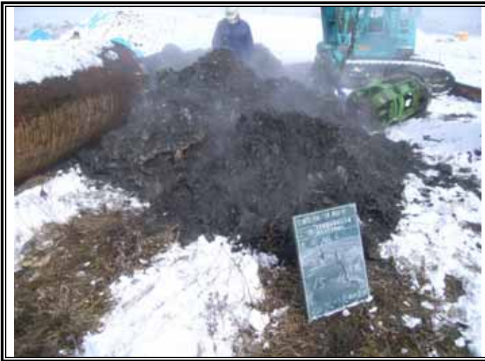
掘削廃棄物土(GL-15.00~-18.00m)
