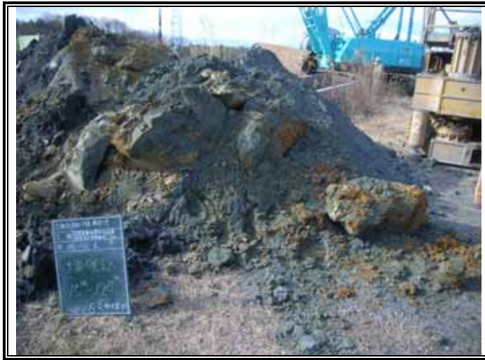
掘削土堆山(GL-15.00~-17.80m)
