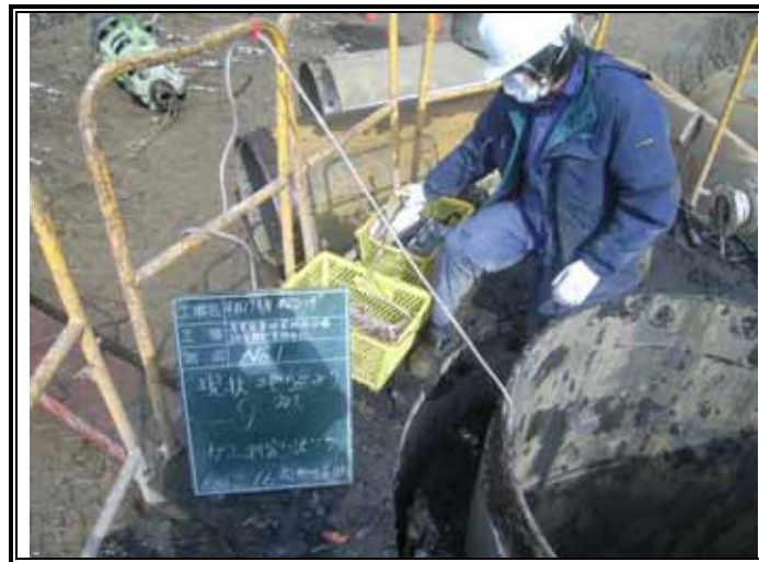
ガス測定状況(GL-9.00m)
