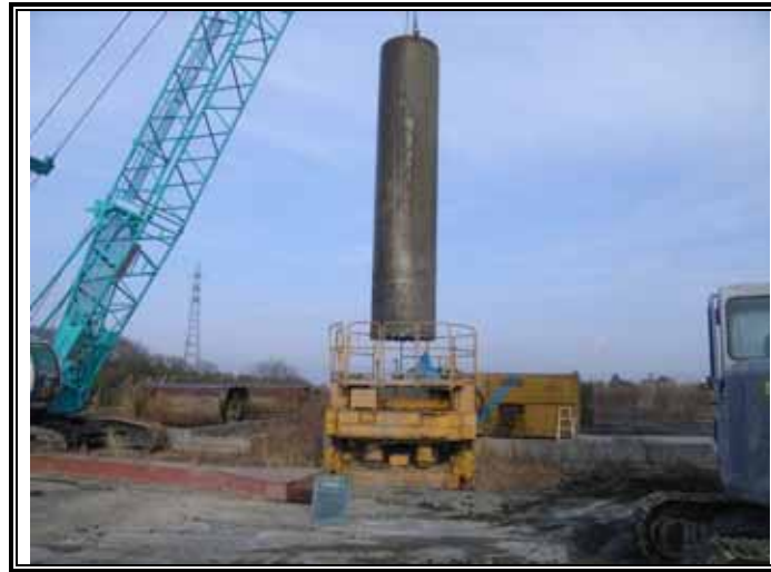
ケーシング立て込み状況
