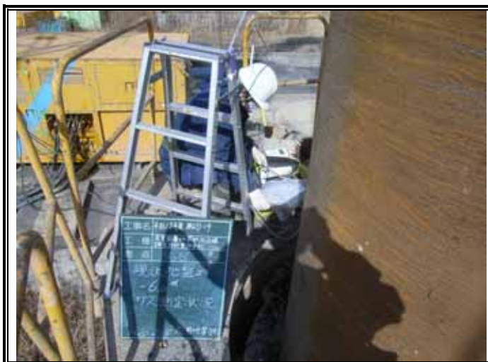
ガス測定状況(GL-6.00m)
