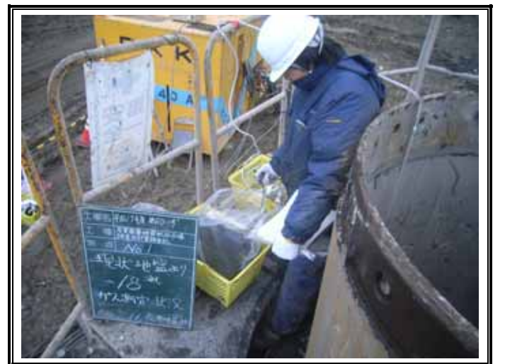
ガス測定状況(GL-18.00m)
