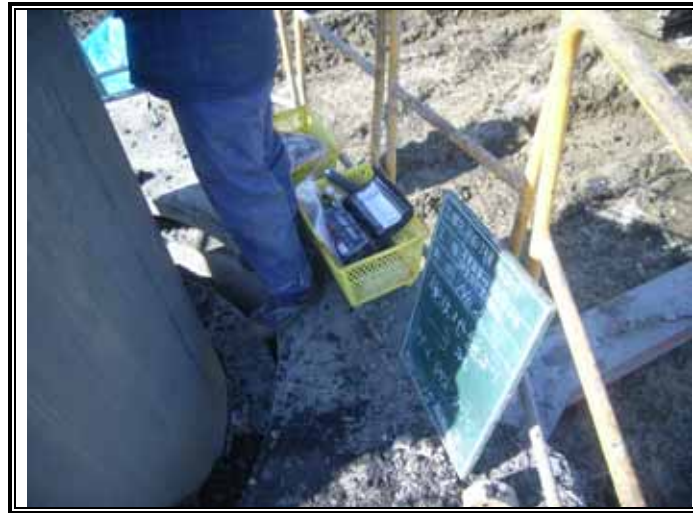
ガス測定状況(GL-3.00m)
