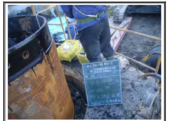
ガス測定状況(GL-18.00m)
