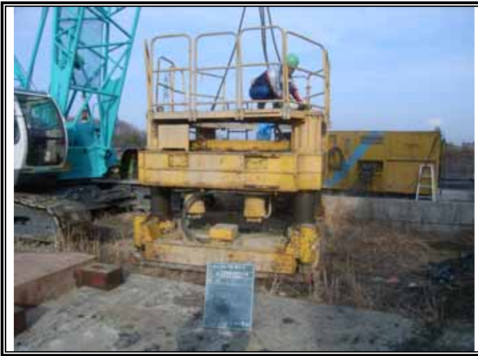
全周回転式油圧ジャッキ設置
