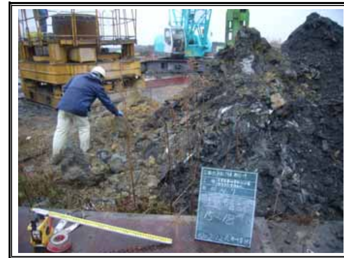
掘削廃棄物土(GL-15.00~-18.00m)
