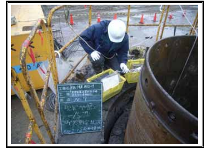
ガス測定状況(GL-15.00m)
