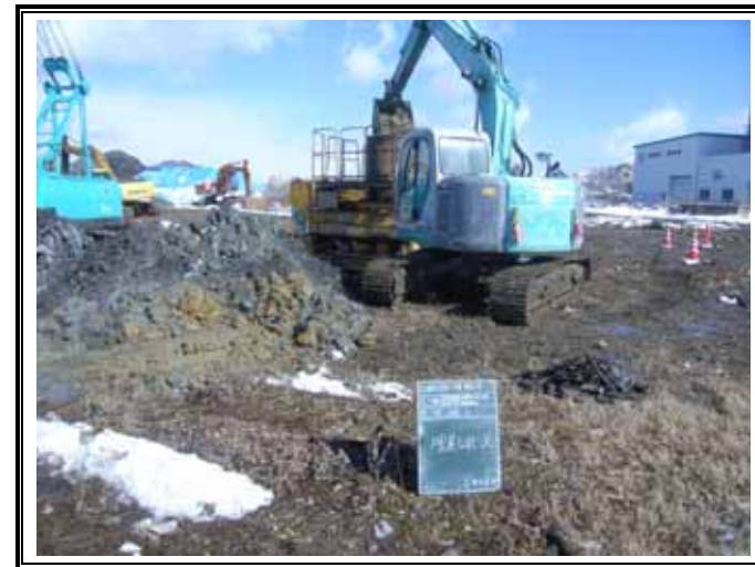
バックホウによる埋戻状況
