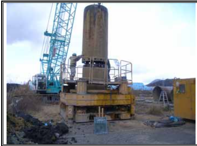
ケーシング立て込み状況
