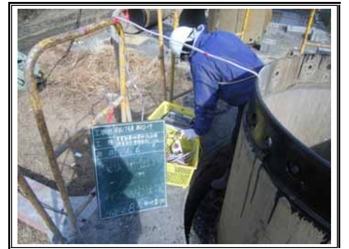
ガス測定状況(GL-12.00m)
