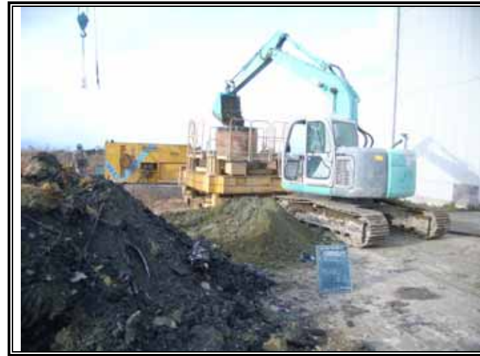
バックホウによる埋戻状況
