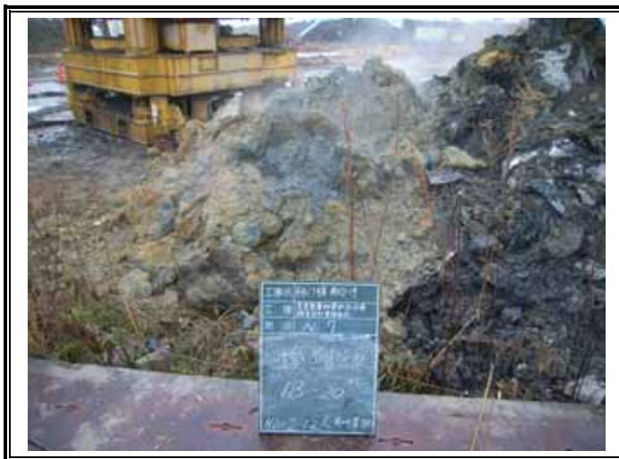
掘削廃棄物土(GL-18.00~-20.00m)
