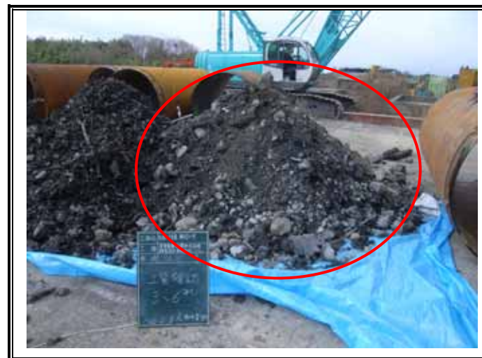
掘削廃棄物土(GL-3.00 ~ -6.00m)
