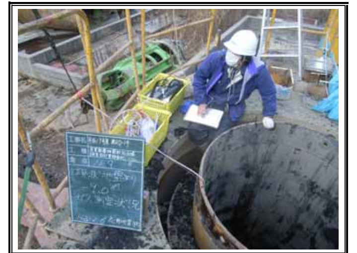
ガス測定状況(GL-9.00m)
