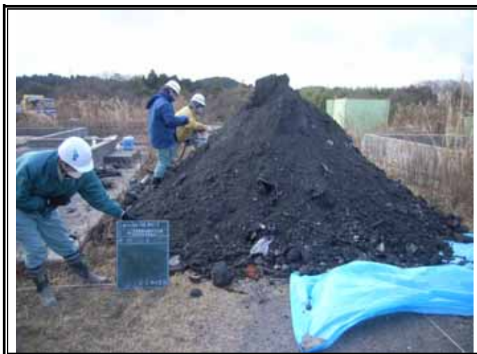
掘削廃棄物土(GL-9.00~-12.00m)
