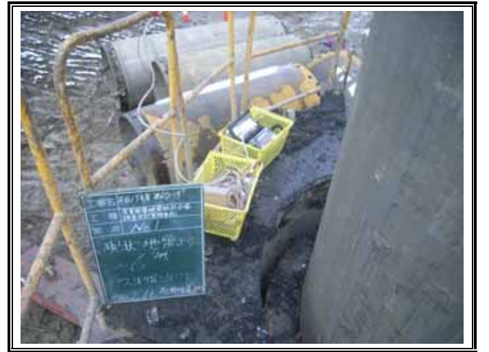
ガス測定状況(GL-6.00m)
