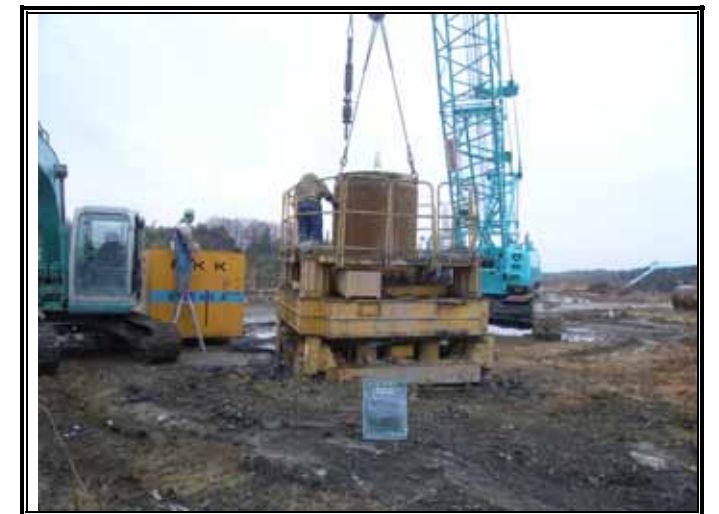
ケーシング抜管状況
