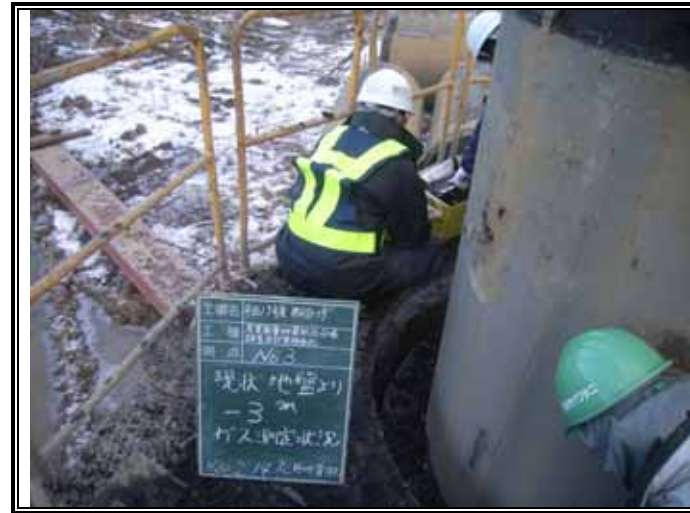
ガス測定状況(GL-3.00m)
