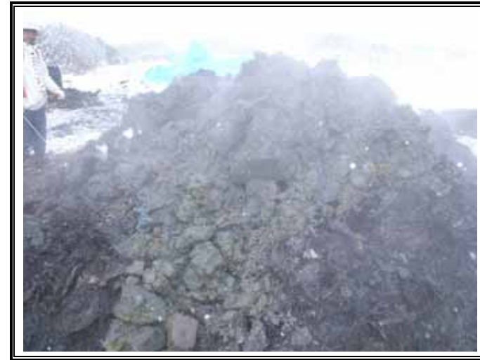
掘削廃棄物土(GL-18.00~-21.00m)
