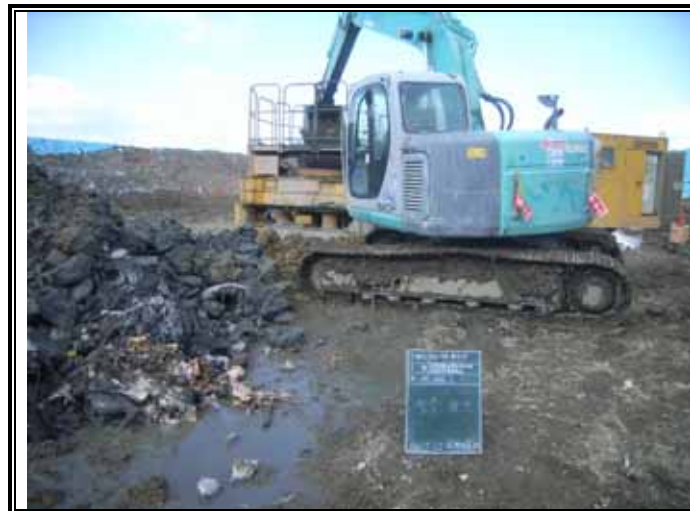
バックホウによる埋戻状況
