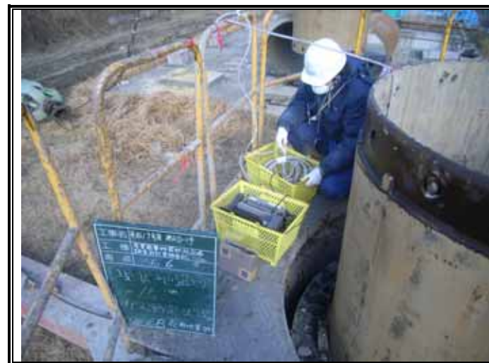
ガス測定状況(GL-15.00m)
