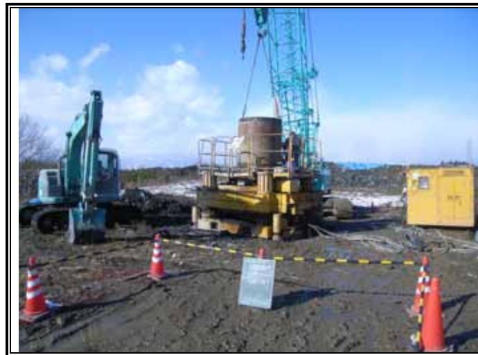
ケーシング抜管状況
