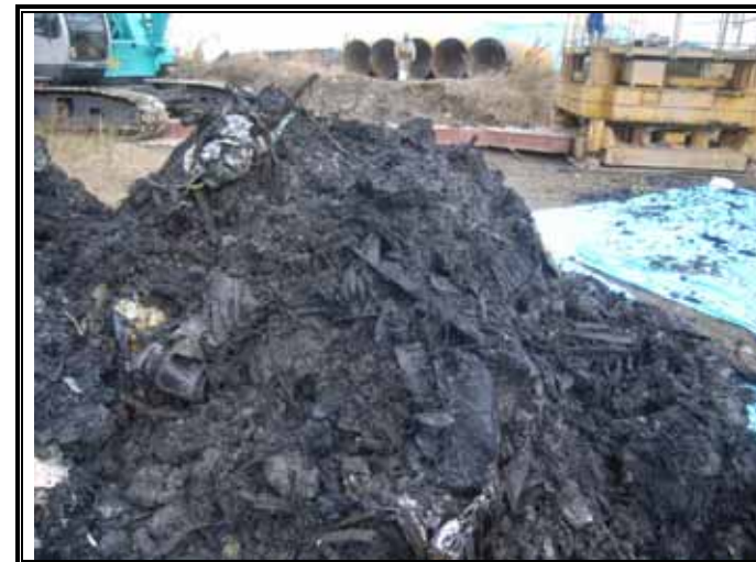
掘削廃棄物土(GL-6.00~-9.00m)
