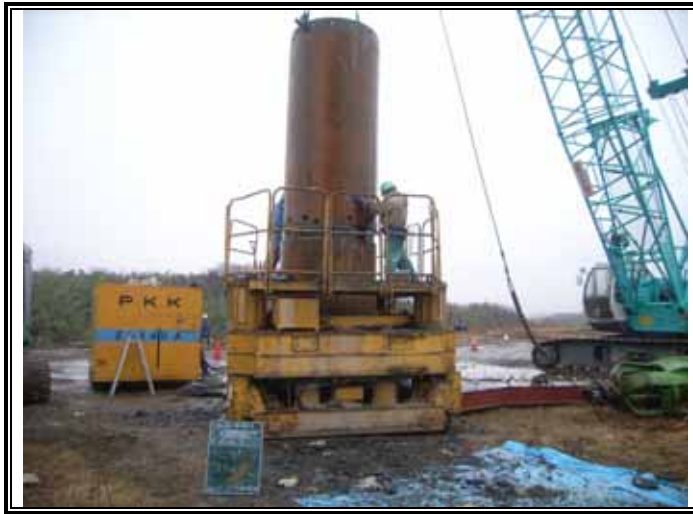
ケーシング立て込み状況
