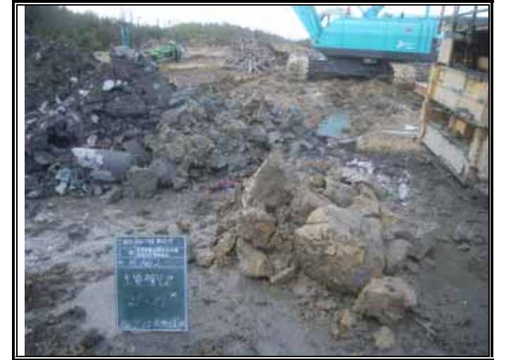
掘削土地山(GL-21.00 ~ -24.00m)
