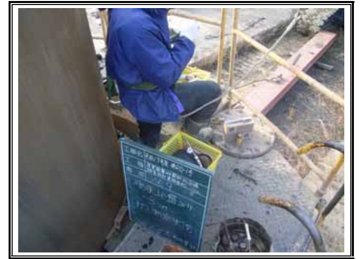
ガス測定状況(GL-3.00m)
