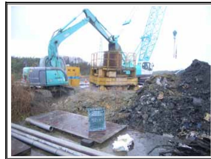
バックホウによる埋戻状況
