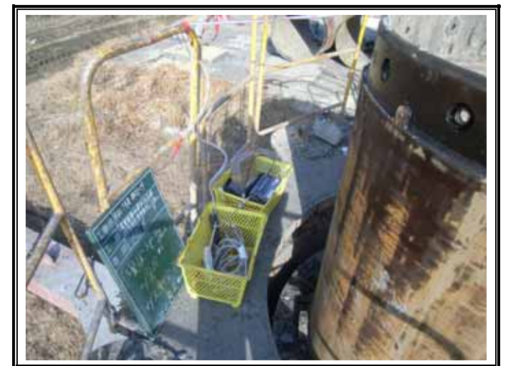
ガス測定状況(GL-17.80m)
