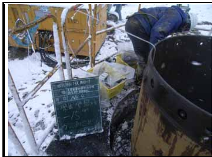
ガス測定状況(GL-15.00m)
