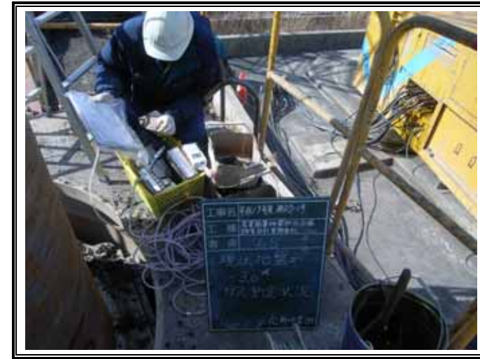
ガス測定状況(GL-3.00m)
