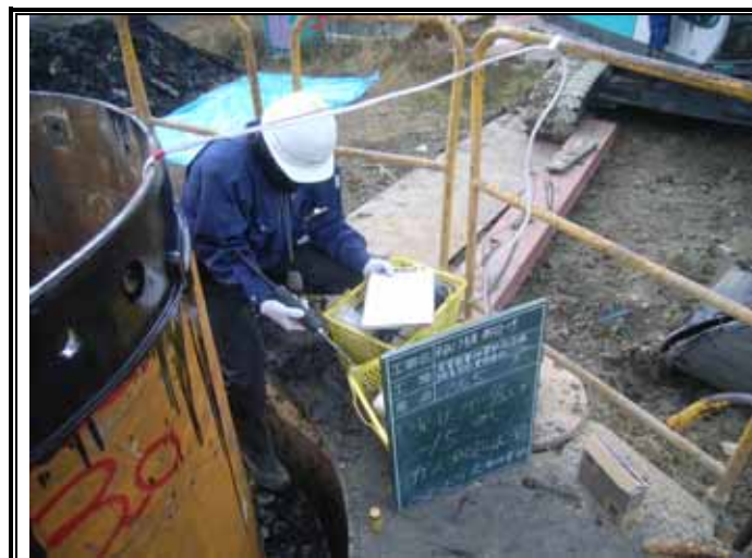
ガス測定状況(GL-15.00m)
