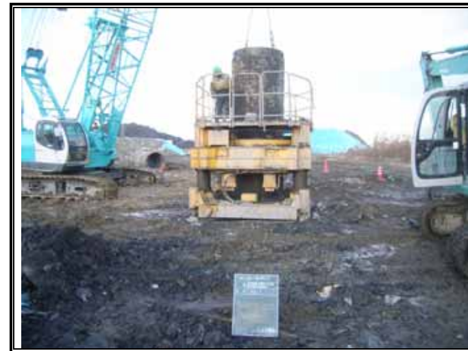
ケーシング抜管状況
