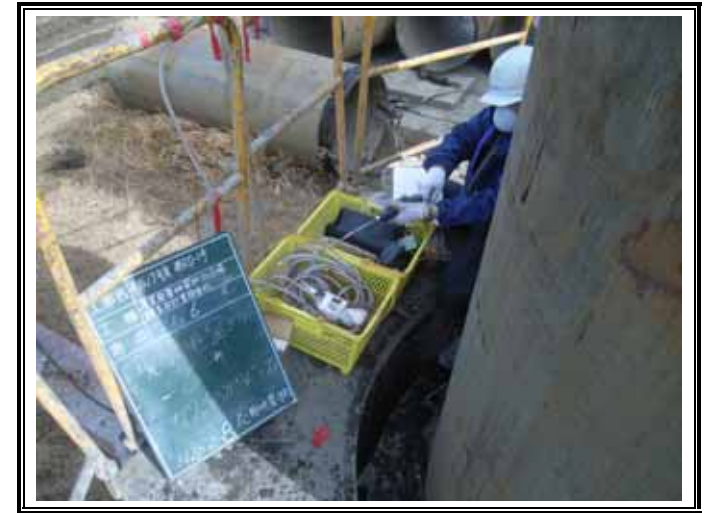
ガス測定状況(GL-6.00m)
