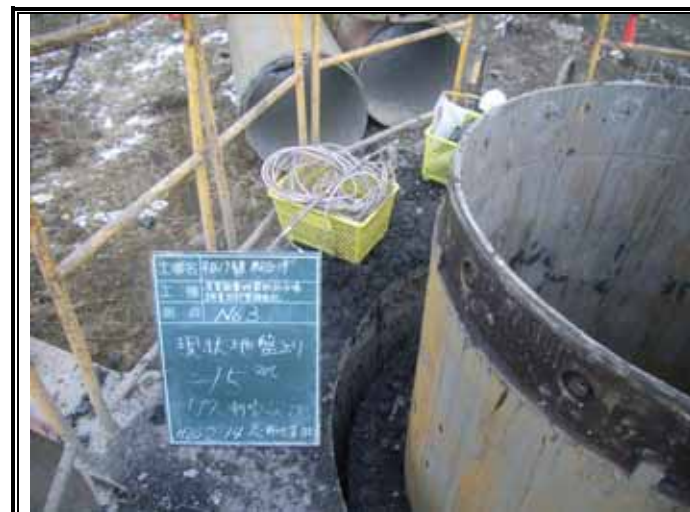
ガス測定状況(GL-15.00m)
