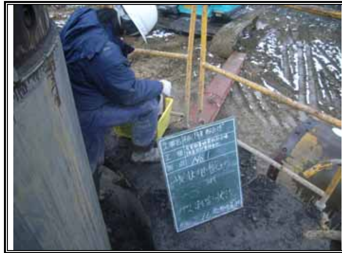
ガス測定状況(GL-3.00m)
