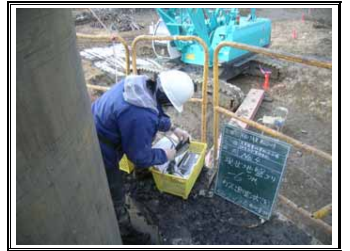
ガス測定状況(GL-6.00m)
