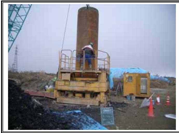
ケーシング立て込み状況
