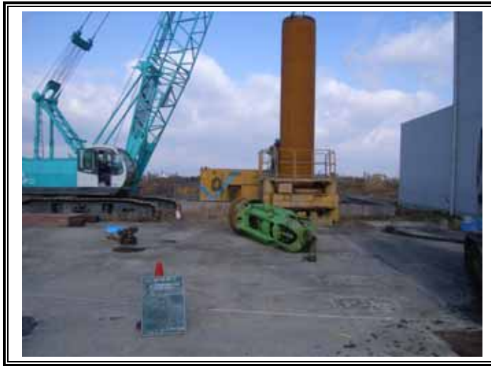
ケーシング立て込み状況
