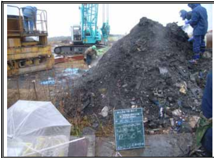
掘削廃棄物土(GL-12.00~-15.00m)
