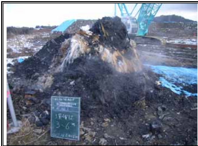
掘削廃棄物土(GL-3.00~-6.00m)
