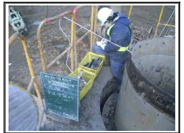
ガス測定状況(GL-18.00m)
