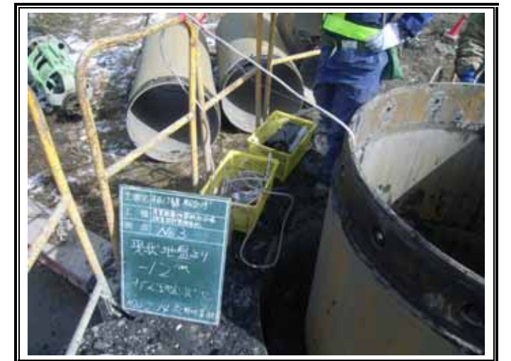
ガス測定状況(GL-12.00m)
