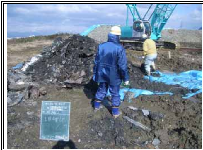
掘削廃棄物土(GL-3.00~-6.00m)
