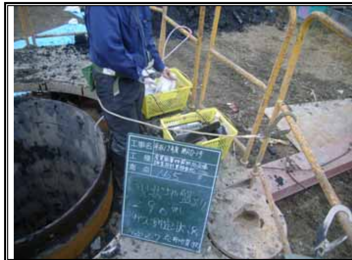
ガス測定状況(GL-9.00m)
