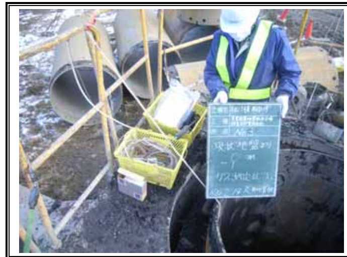
ガス測定状況(GL-9.00m)
