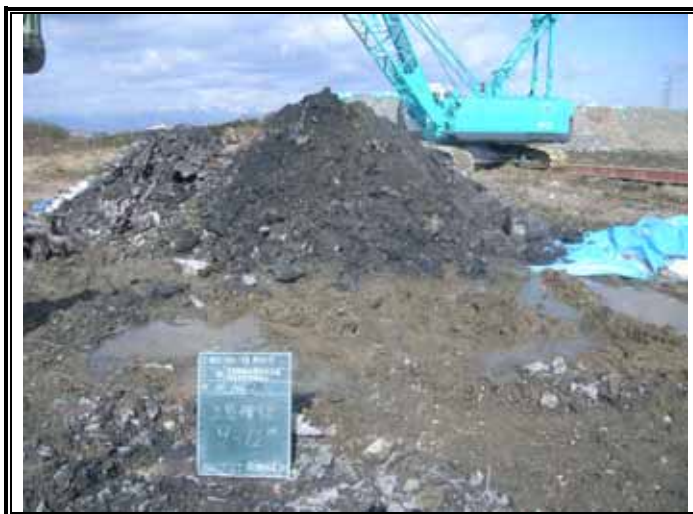
掘削廃棄物土(GL-9.00~-12.00m)
