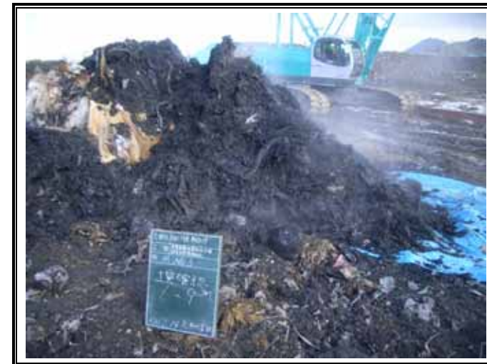
掘削廃棄物土(GL-6.00~-9.00m)
