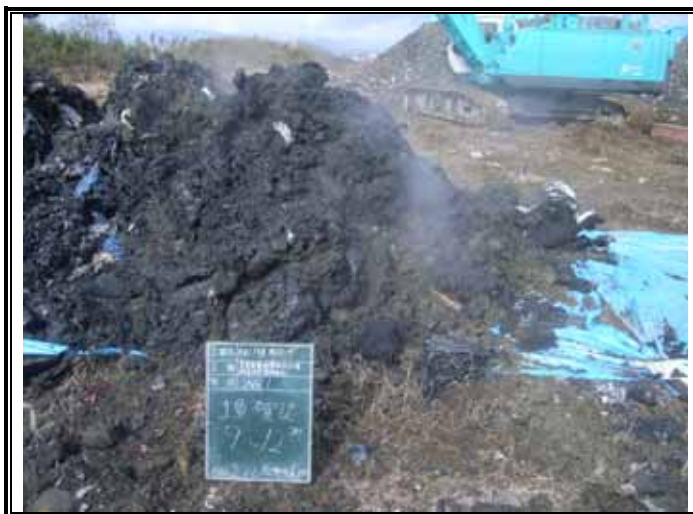
掘削廃棄物土(GL-9.00～-12.00m)
