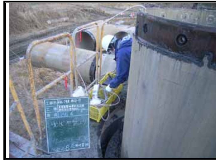
ガス測定状況(GL-3.00m)
