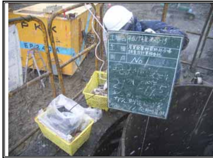
ガス測定状況(GL-21.00m)
