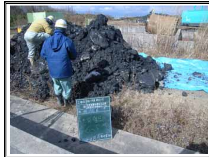
掘削廃棄物土(GL-6.00~-9.00m)
