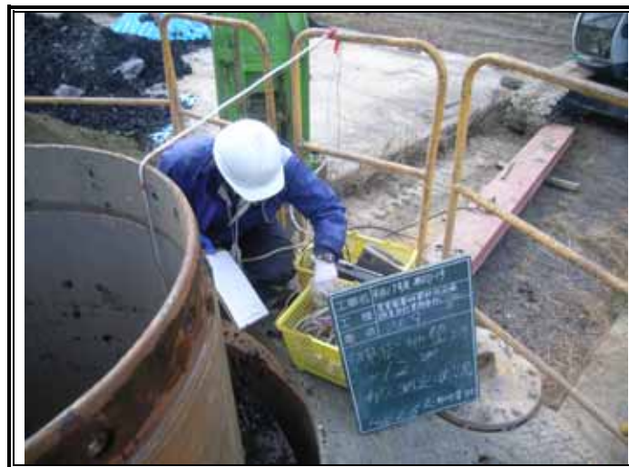
ガス測定状況(GL-12.00m)
