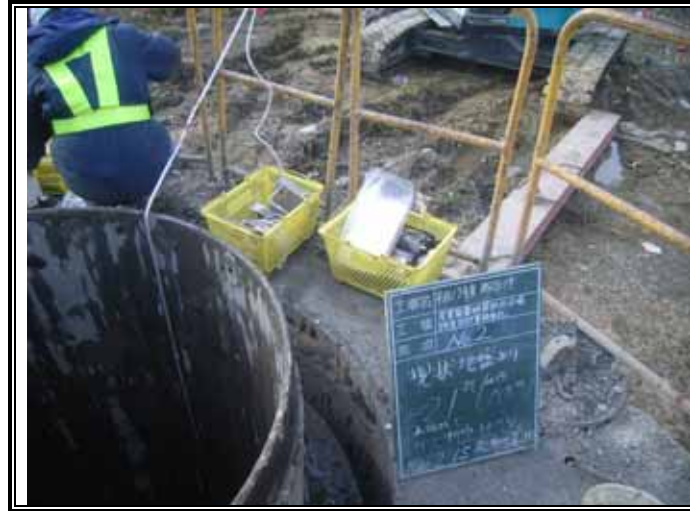
ガス測定状況(GL-21.00m)
