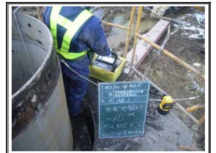
ガス測定状況(GL-18.00m)
