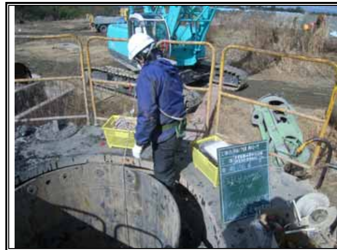
ガス測定状況(GL-9.00m)
