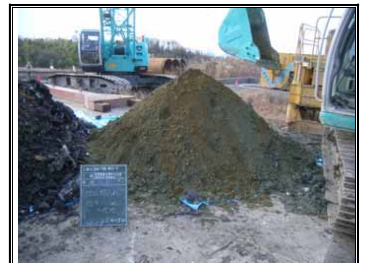
掘削土地山(GL-12.30 ~ -15.35m)
