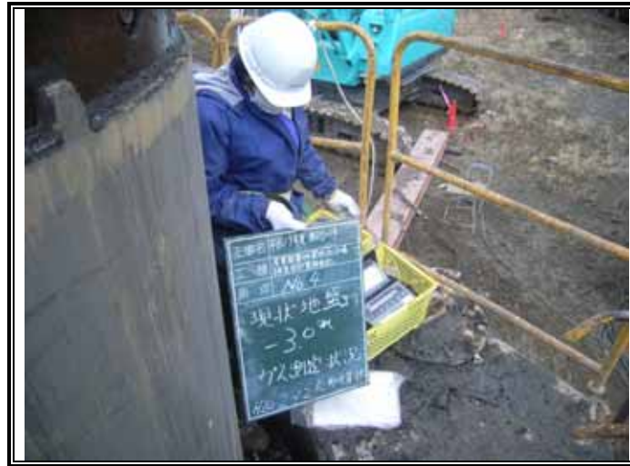
ガス測定状況(GL-3.00m)
