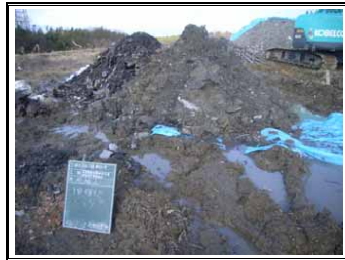
掘削廃棄物土(GL-6.00~-9.00m)
