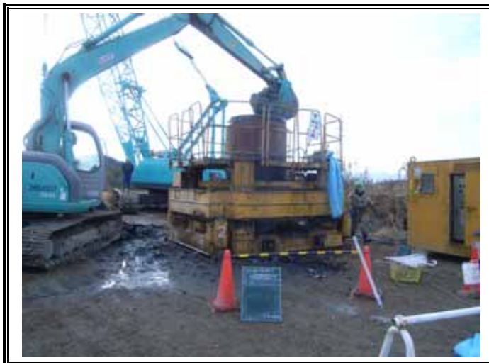
バックホウによる埋戻状況
