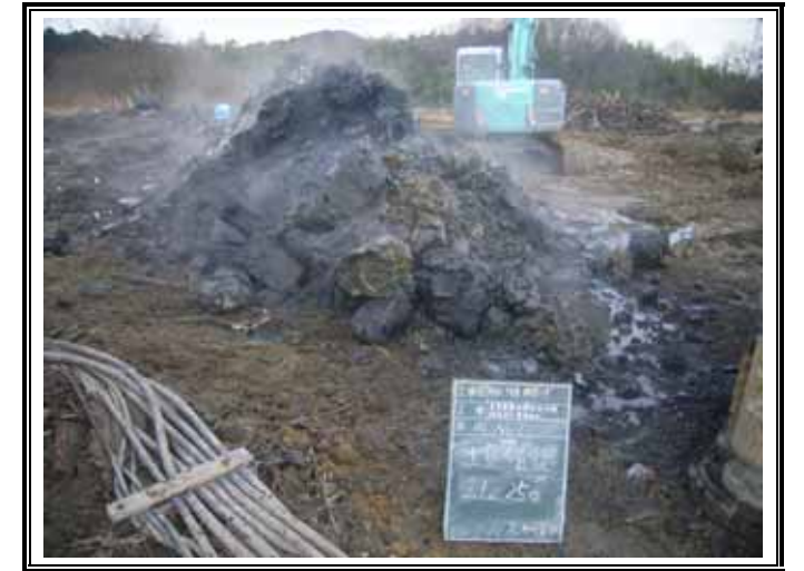
掘削土地山(GL-21.00 ~ -25.00m)
