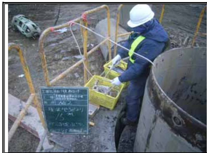
ガス測定状況(GL-15.00m)
