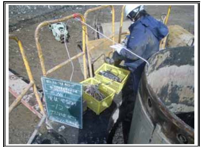
ガス測定状況(GL-12.00m)
