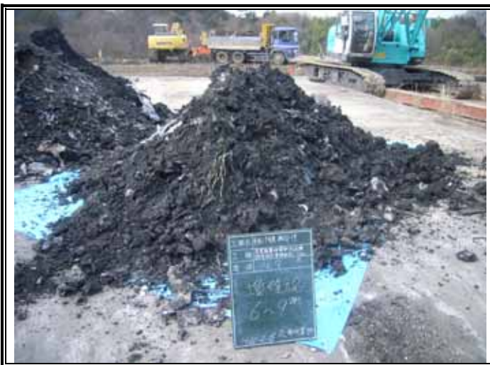
掘削廃棄物土(GL-6.00 ~ -9.00m)
