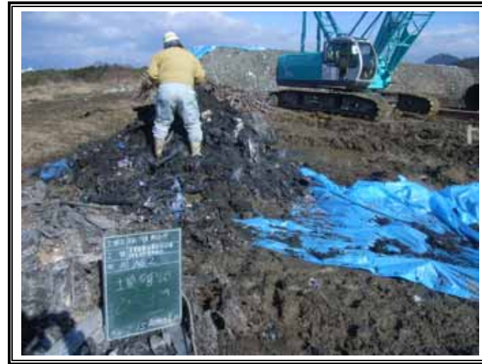
掘削廃棄物土(GL-3.00~-6.00m)
