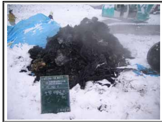
掘削廃棄物土(GL-6.00~-9.00m)
