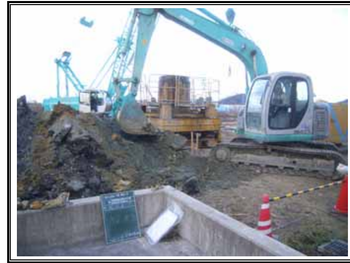
バックホウによる埋戻状況
