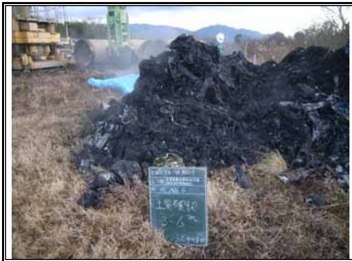
掘削廃棄物土(GL-3.00~-6.00m)
