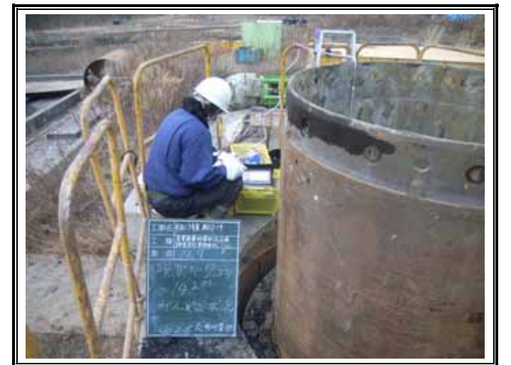
ガス測定状況(GL-14.20m)
