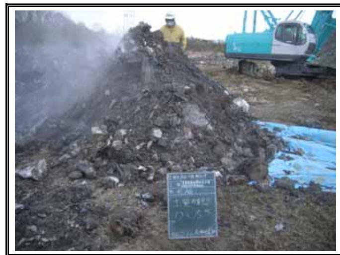
掘削廃棄物土(GL-12.00～15.00m)
