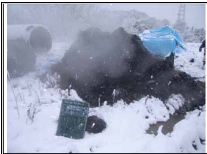
掘削廃棄物土(GL-9.00~-12.00m)
