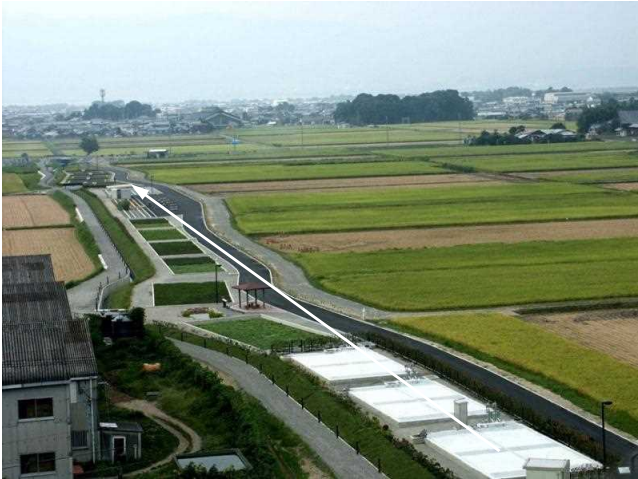
市街地排水浄化施設
