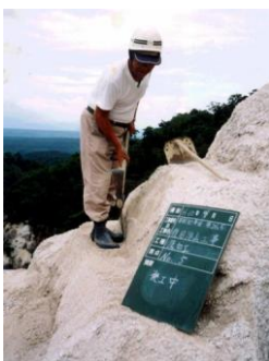
○急傾斜地での筋工
