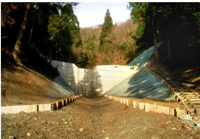
○予防治山工事
