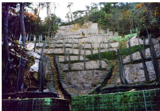
○治山工事施工後
