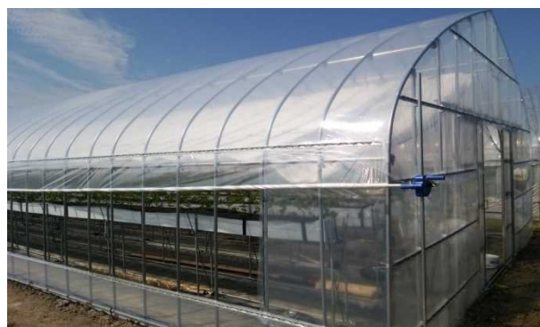
再建されたイチゴ栽培ハウス
