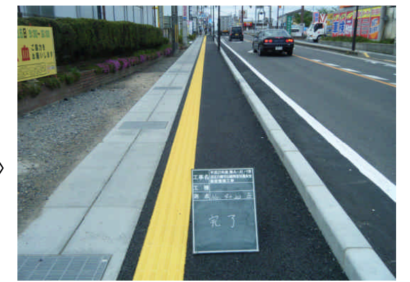
工事後 (平成22年5月完了区間)
