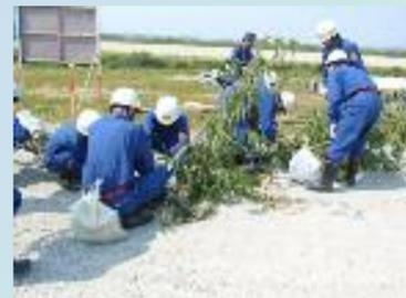
日野町消防団は、木流し工法(左)とシート張り工法(右)を実施。枝葉の多い木やシートによって、堤防が削られるのを防止します。
