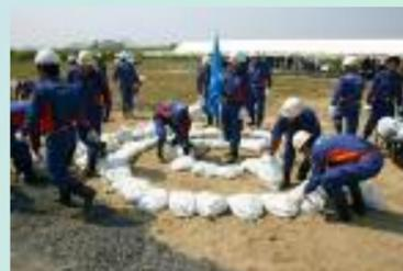
東近江市消防団が釜段工(左)を、近江八幡市消防団は月の輪工(右)を実施。どちらも土のうを積み重ねて漏水する水を溜めます。
