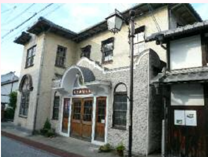
モダンな外観の 素敵な建物 旧八幡郵便局
