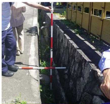
避難時の危険箇所 家の出口東側に水路の段差
