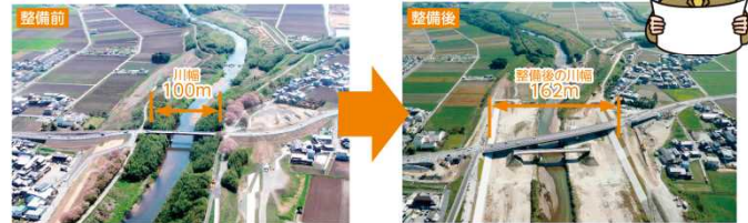
日野川では、工事の結果、1.3倍の水を流せるようになりました。
