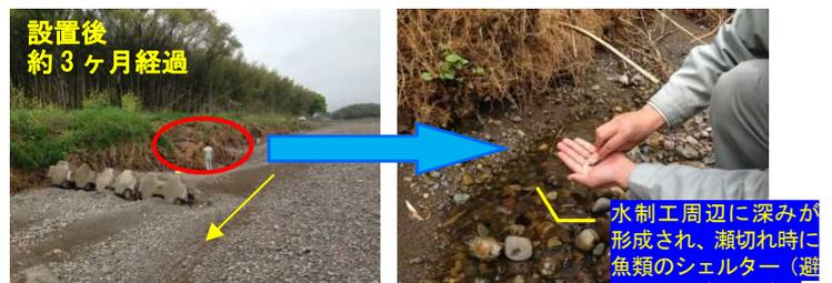
写真 2 試験施工箇所のモニタリング・施工後約 3 ヶ月経過（H26. 5. 1 撮影）
