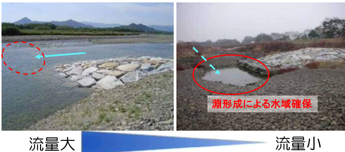
図 4.4 水制工によるシェルター（避難場）の形成例（土器川、香川県）
