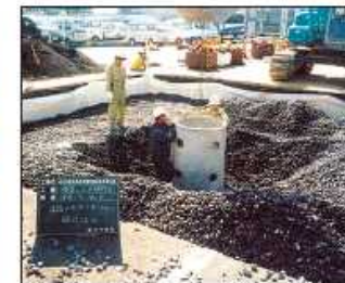
大型浸透ますの施工状況
