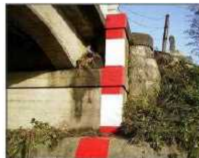
簡易量水標の設置
