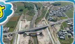
河川の改修工事、適正な維持管理
