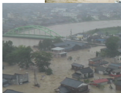
新潟県中之島町の浸水状況
