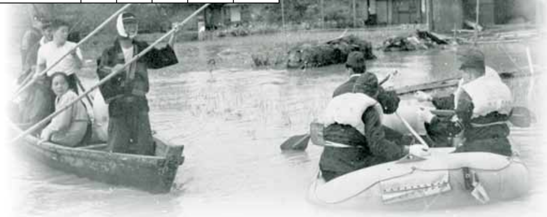
昭和34年伊勢湾台風による浸水状況(野洲市小南)
