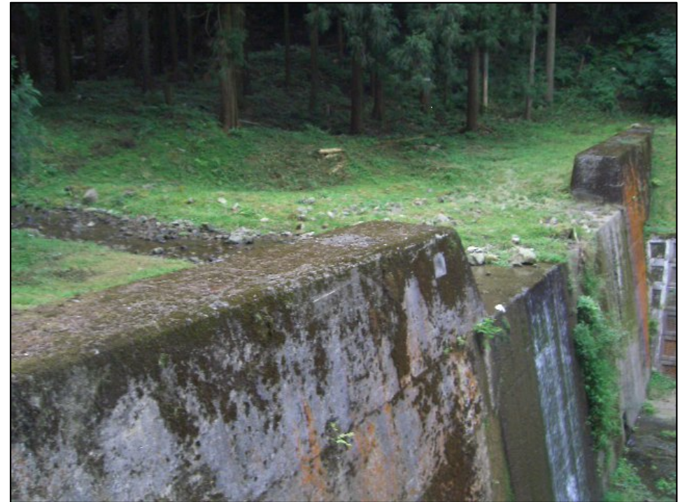
撮影日：2009年9月2日 堆砂する砂防堰堤の様子
