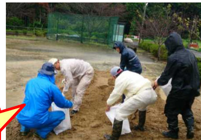
【土のう作業状況(H25T18発生時)】
