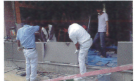
決意の川床工事一窓を大改造
