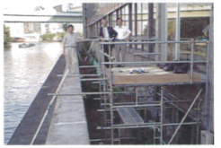
修理工事に、模擬川床が出現
