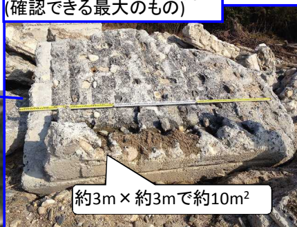
決壊箇所のコンクリート片 (確認できる最大のもの)
