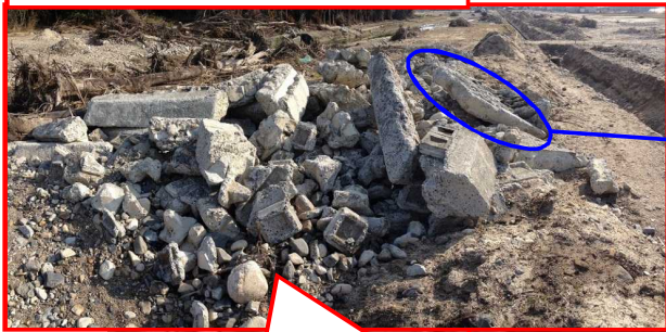
決壊箇所のコンクリート片の集積箇所
