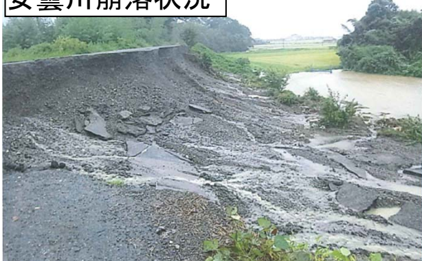
安曇川崩落状況
