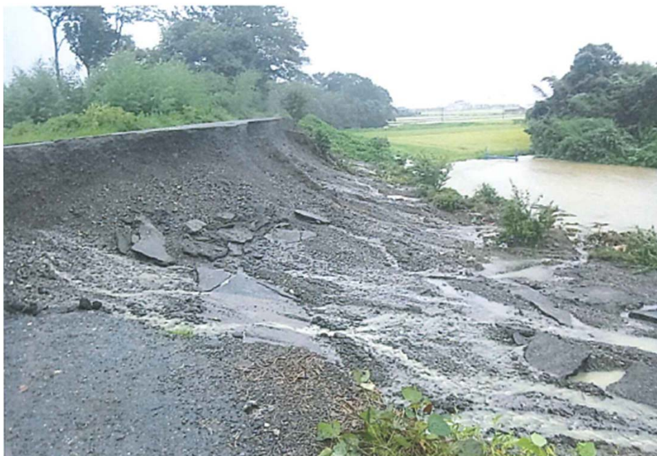
安曇川崩落状況
