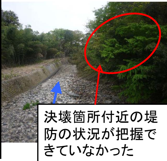
野田橋下流写真(2013/5/10時点)
