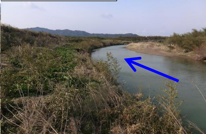
上流から河道内を望む
