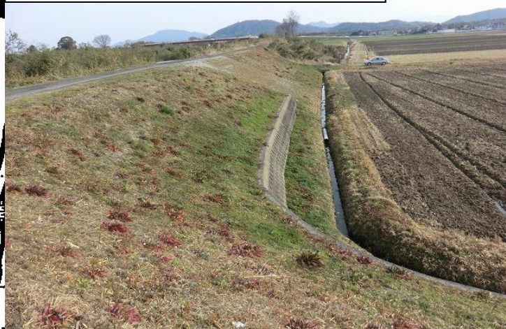
下流堤防上より崩落箇所を望む
