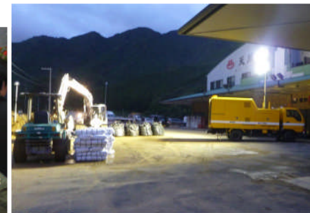
照明車の活躍により夜間の視認性を確保し県道復旧工事用土のうを作成(那智勝浦町)
