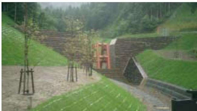
曲谷川 砂防堰堤
