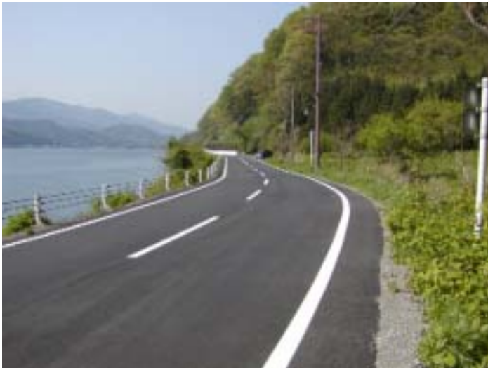
葛籠尾崎大浦線 道路補修工事（舗装）
