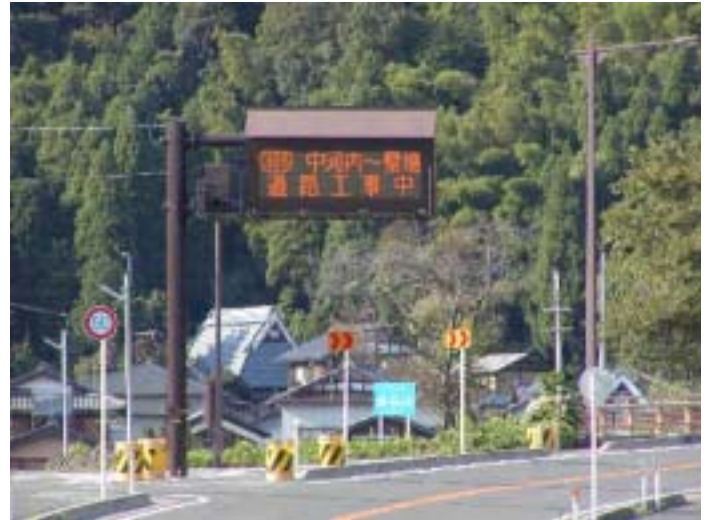
国道365号 交通安全施設整備工事（道路情報表示板）
