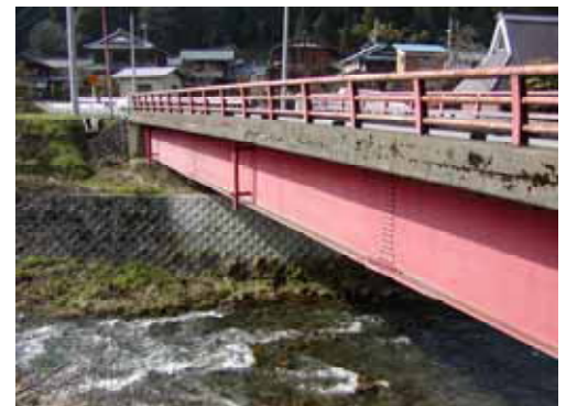
[杉野橋(対策工事未): 木之本町]
