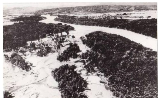
旧安曇川町川島地先の堤防決壊状況
