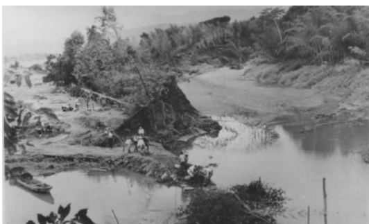
旧安曇川町二ツ矢地先の堤防決壊状況
