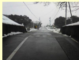
図6 大井 切り通し(左岸側)
