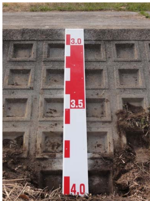
T-9(長浜市保延寺地先) 低水護岸
