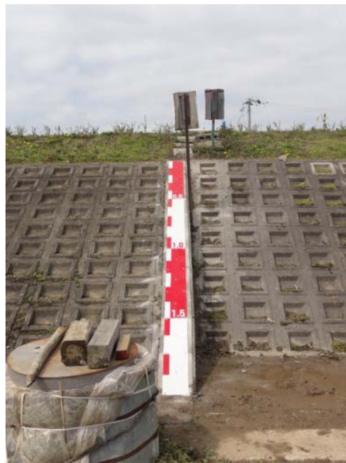
T-9(長浜市保延寺地先) 低水護岸
