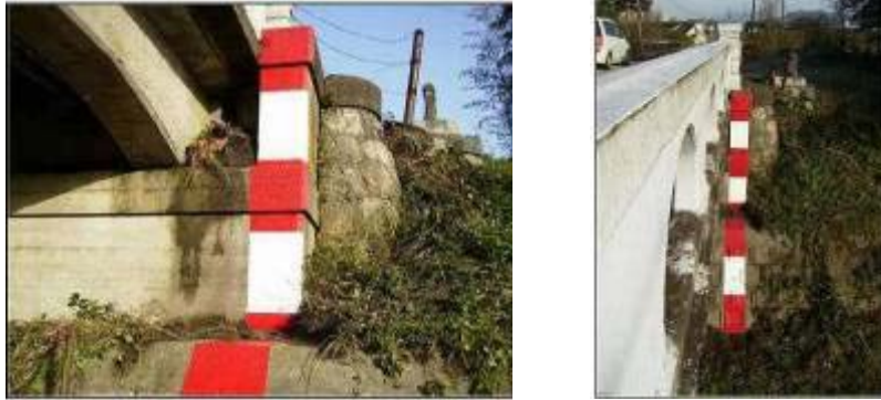
T-3(長浜市馬渡地区、馬渡橋左岸護岸部橋梁下)
