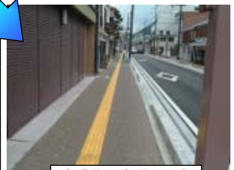
完成後の歩道の写真
