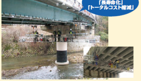
■橋梁点検の様子
