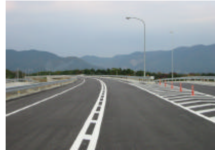
中河内木之本線 《徐呉町菅並～上丹生、約2.5km》 平成13年12月10日開通！
