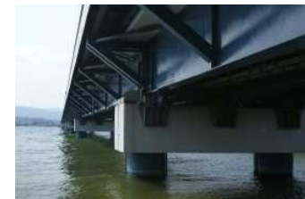
パイルベント橋脚部
