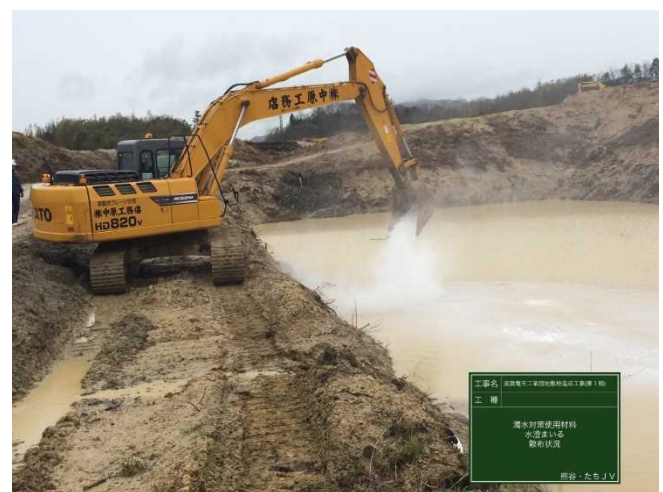
図-4 凝集剤散布状況
