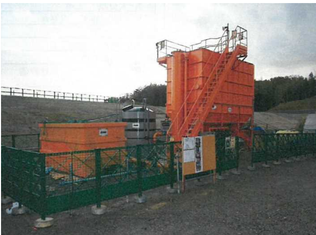
図-6 濁水処理機稼働状況
