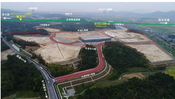
図-1 工業団地現況航空写真
