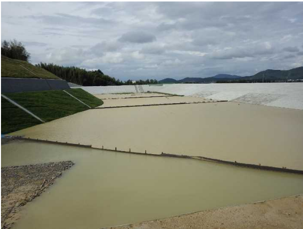
図-5 調整池仕切り柵設置状況
