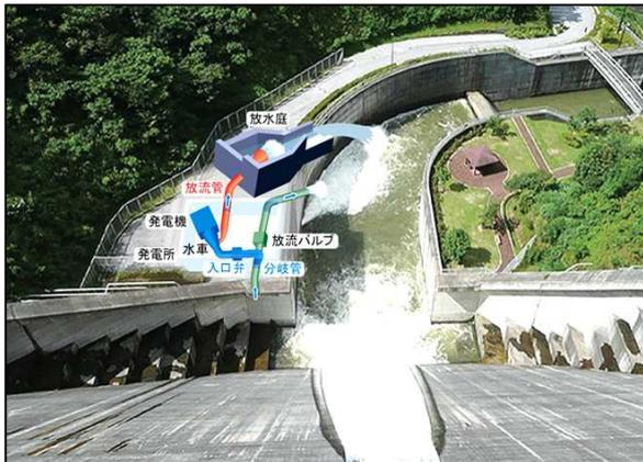
図-4 水力発電設備配置図 1)
