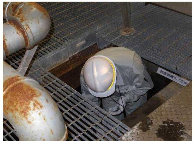
図-1 漏水量手動計測
