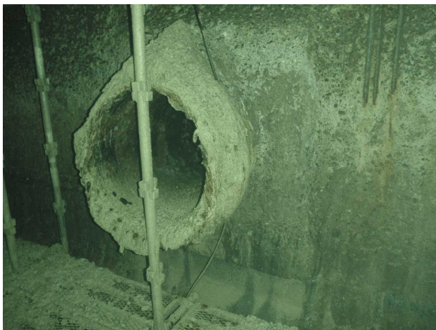
写真-2 ポンプ吐出管腐食状況
