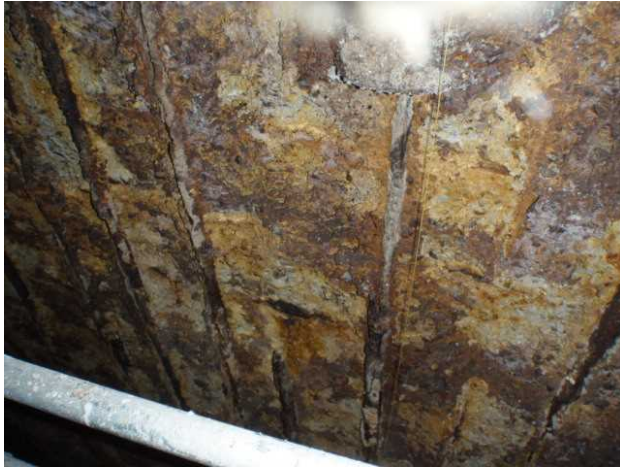
写真-1 鉄筋露出，破断状況
