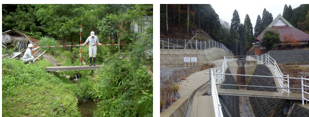
写真-2 急傾斜・砂防工事
