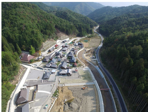
写真-1 現在の上水谷地区 (H27.10.22撮影)
