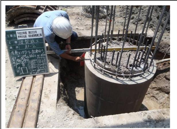
写真-2 対策状況（場所打ちコンクリート杭の築造）
