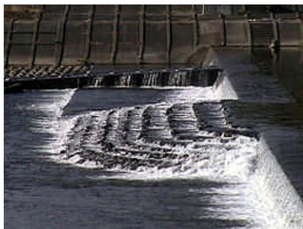
図-5 棚田式魚道設置事例(岐阜県 根尾川)
