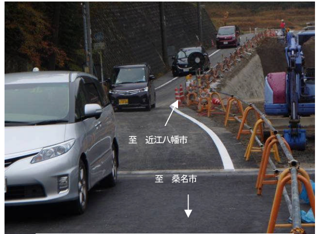
図8 施工中の交通状況
