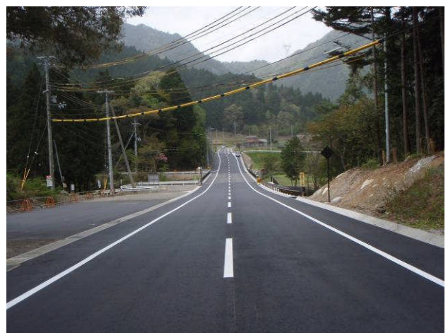
図10 神崎橋周辺工事変遷 上段：施工前 下段：施工後
