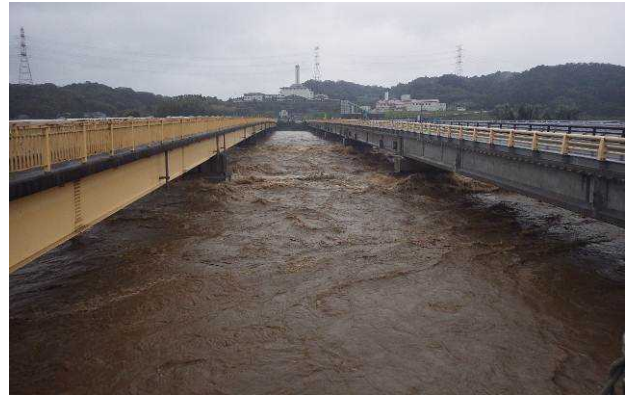
(写真-3 平成25年台風18号による出水状況)
