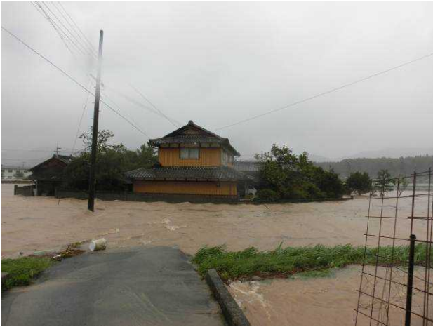
(写真-6 河川氾濫による家屋浸水状況)
