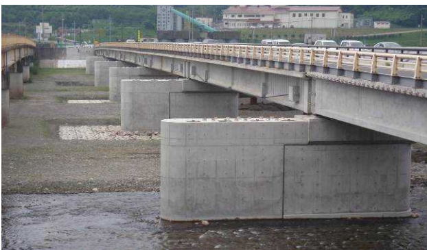
(写真-2 新設橋+既設新橋 完成後)
