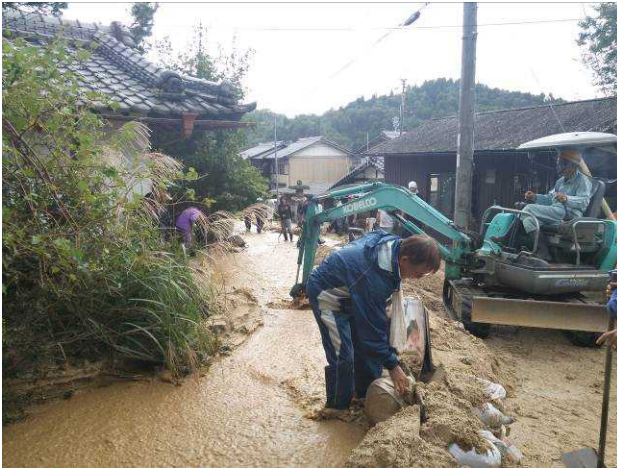
(写真-7 浸水防止のための土のう設置)
