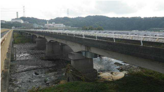
(写真-1 既設旧橋 施工前)
