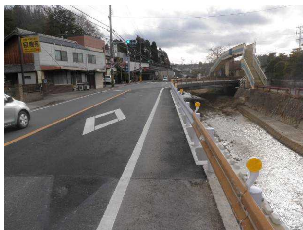
(写真5 国道307号復旧後の状況)
