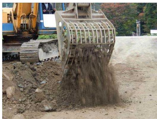
写真-2 スケルトンによる混合状況
