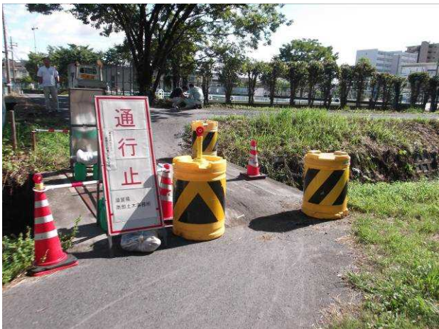
図-3 通行止め措置の状況
